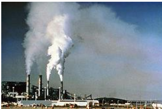
Figura 8.40. Las plantas de cemento son las grandes fuentes de contaminación atmosférica.
