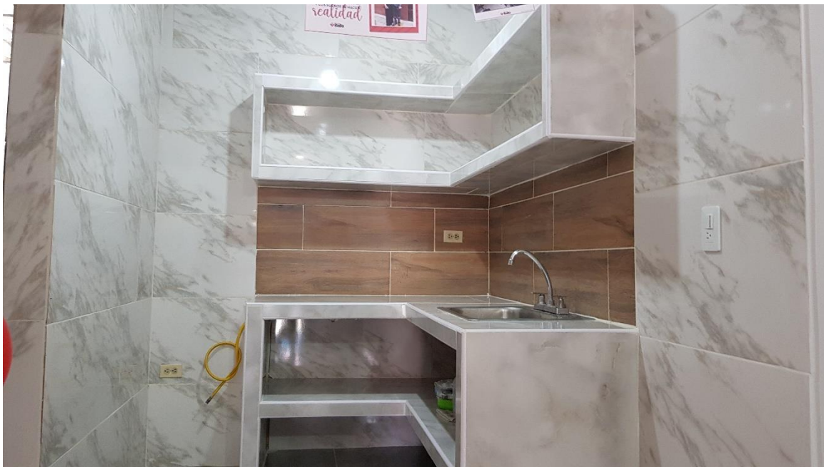
Ilustración 81 Registro fotografico#3_Intervencion Yhon Casas
