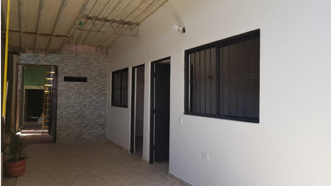
Ilustración 63 Registro fotografico#1_Intervención German Rincón
