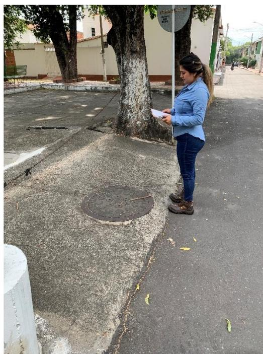
**SEGMENTO 8: ENCONTRAMOS EN UN PAVIEMNTO FLEXIBLE UNA FORMACION DE BACHES, DESGASTE SUPERFICIAL Y FALLA LONGITUDINAL Y TRANSVERSAL.**
