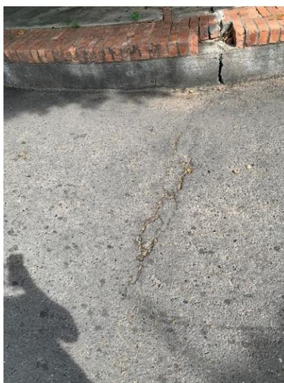
SEGMENTO 2: ENCONTRAMOS FALLA TRANSVERSAL Y LONGITUDINAL CON DESGASTE SUPERFICIAL EN UN TIPO DE PAVIEMTO FLEXIBLE.
