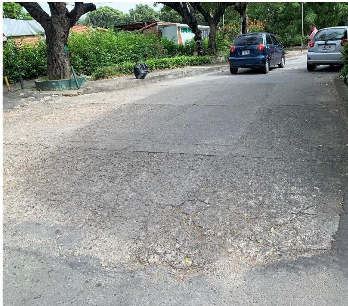
**SEGMENTO 5: ENCONTRAMOS UN PAVIMENTO RIGIDO CON DESGASTE SUPERFICIAL, AGRIETAMIENTO, DAÑO DE JUNTAS Y HUNDIMIENTOS.**
