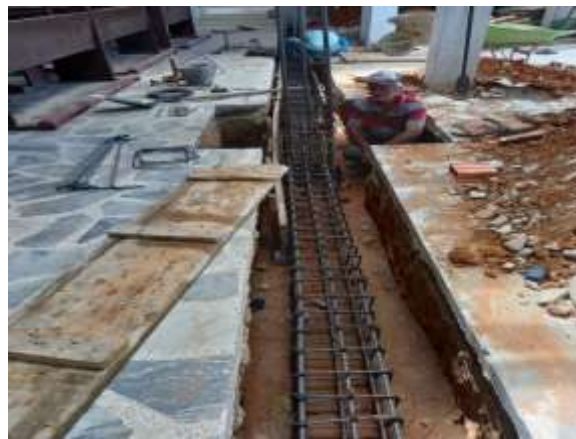
Ilustración 13. Construcción Viga de Cimentación (Anexos)
