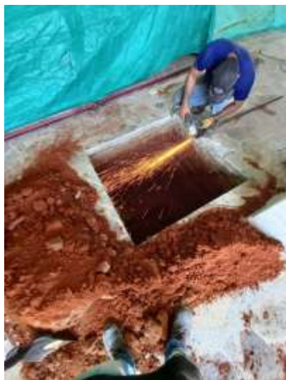
Ilustración 8. Excavación en mármol Zapata/Viga
