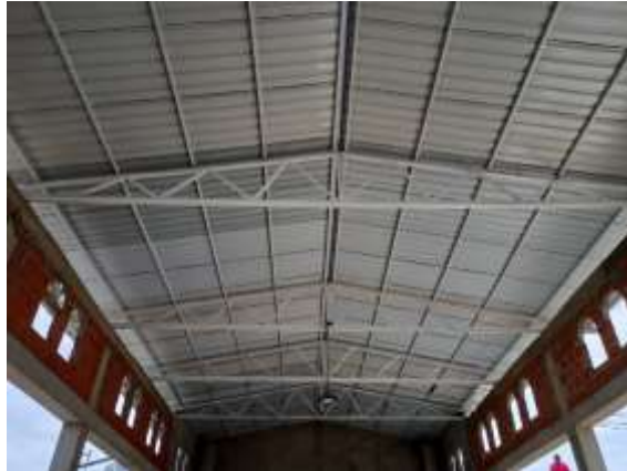
Ilustración 26. Cubierta Central (Anexos)
