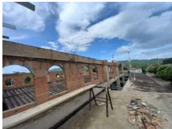
Ilustración 23. Viga de Amarre V40 (Anexos)
