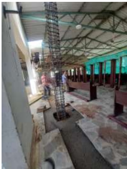
Ilustración 14. Relleno y Ante Piso de Nivelación (Anexos)
