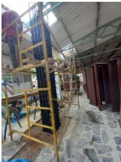
Ilustración 16. Construcción de Columnas (Anexos)
