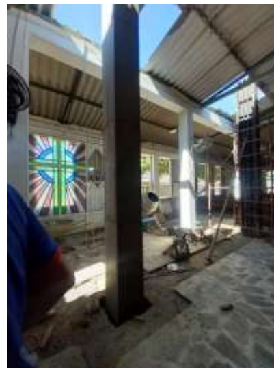
Ilustración 17. Construcción de Columnas (Anexos)
