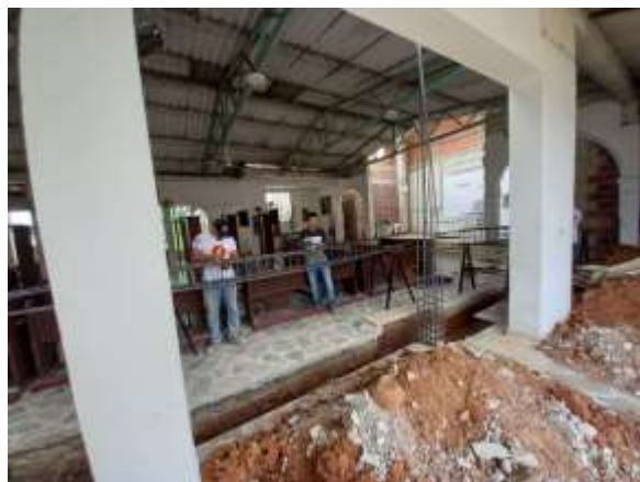
Ilustración 12. Construcción Viga de Cimentación (Anexos)
