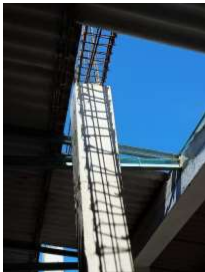
Ilustración 18. Construcción Viga V30 (Anexos)
