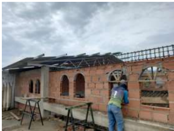
Ilustración 22. Viga de Amarre V40 (Anexos)
