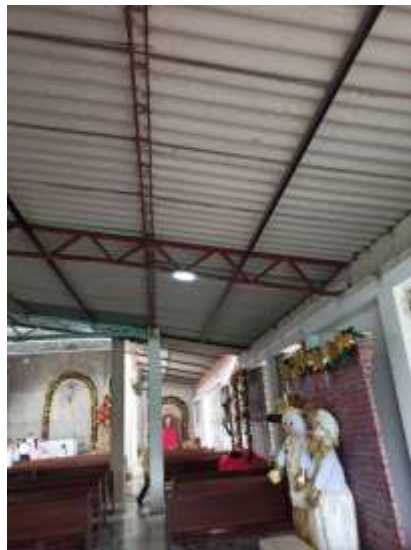
Ilustración 27. Cubierta Lateral (Anexos)
