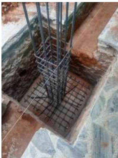
Ilustración 10. Construcción Zapatas (Anexos)
