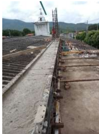
Ilustración 19. Construcción Viga V30 (Anexos)
