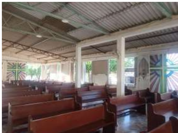
Ilustración 6. Inicio de Remodelación (Anexos)
