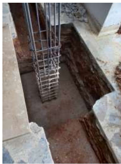
Ilustración 11. Construcción de Zapatas
