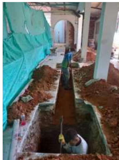
Ilustración 9. Excavación en suelo semiduro.
