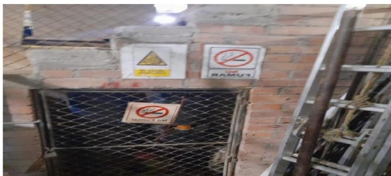
Anexo 14. Almacén de Acueducto Inflamable
