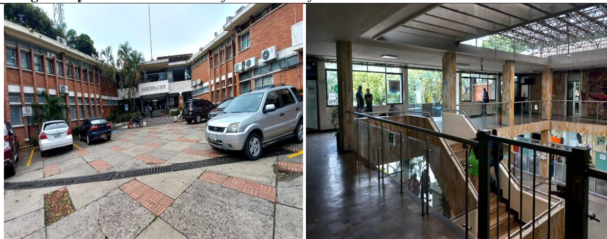
Imagen 27 y 28. Se evidencia la infraestructura física del CAD de la Gobernación de Arauca.
