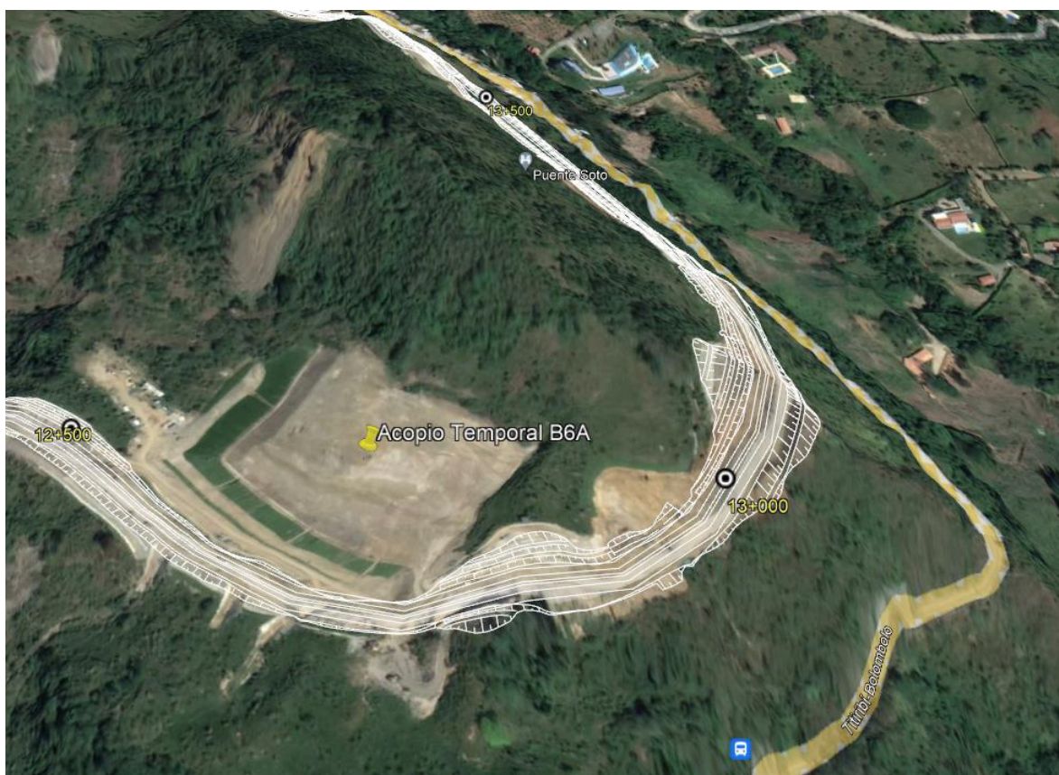
ILUSTRACIÓN 10 – LOCALIZACIÓN DE COORDENADAS PLANAS E=1144909.771 Y N=1156453.416 DEL ACOPIO TEMPORAL B6A (GOOGLE EARTH PRO, 2022)
