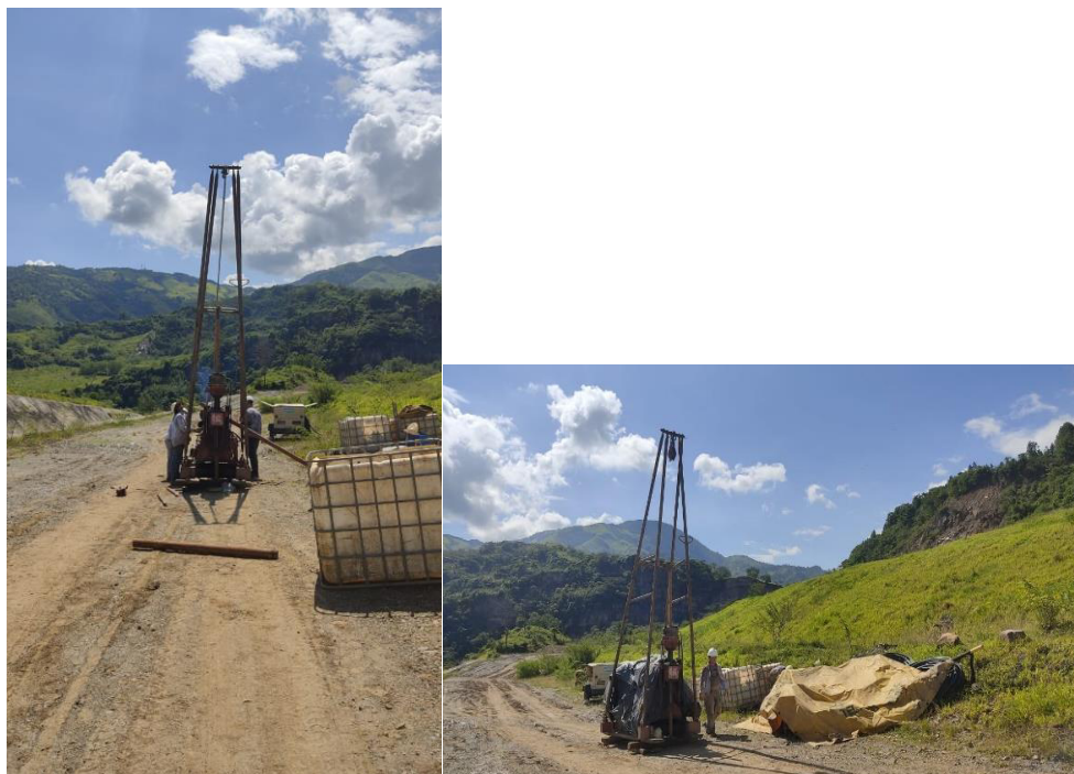
ILUSTRACIÓN 16 – MAQUINA DE PERFORACIÓN A PERCUSIÓN Y ROTACIÓN (FUENTE: PROPIA)
