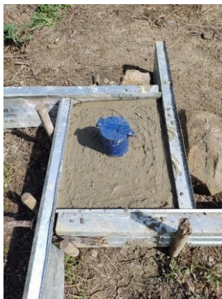
ILUSTRACIÓN 50 – PUNTO DE CONTROL PI – INCLINÓMETRO 01 (FUENTE: PROPIA)
