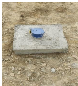
ILUSTRACIÓN 51 – PUNTO DE CONTROL P3 – INCLINÓMETRO 03 (FUENTE PROPIA)
