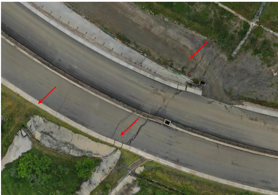
ILUSTRACIÓN 55 – ORTOFOTO VÍA EN CONSTRUCCIÓN ACOPIO TEMPORAL B6A, JUNIO 2022 (PROINVIPACIFICO SAS, 2022)
