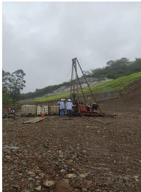
ILUSTRACIÓN 4 – MÁQUINA DE PERFORACIÓN UTILIZADA PARA LA INSTALACIÓN DE LAS TUBERÍAS (FUENTE: PROPIA, FOTOGRAFÍA TOMADA CON TELÉFONO CELULAR)
