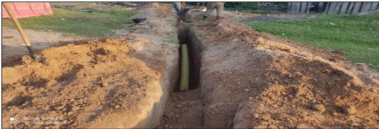
***Construcción de Conexiones Domiciliarias del Sistema de Acueducto, l=7,50mts. (Incluye Excavación y Retapado de Zanja. (No Incluye Cajilla de Medidor)***
