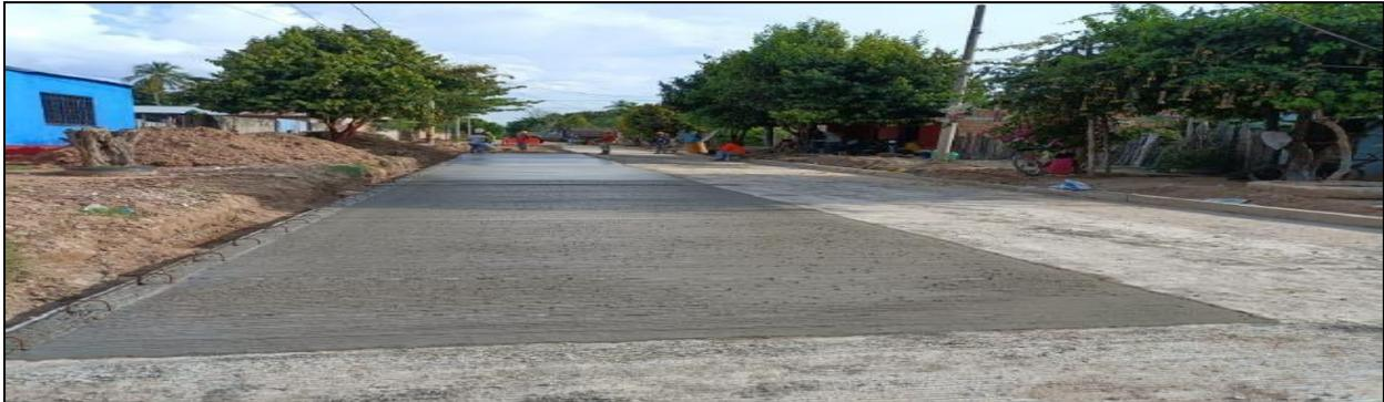
***Bordillos en Concreto Rígido de 3000 psi incluye Refuerzo Según Detalle***
