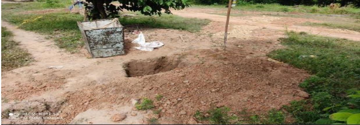
***Cama para Tendido de Tubería en Arena Espesor 10cm***
