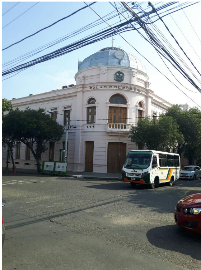
Figura 40. Foto Palacio de la Gobernación con su cúpula chata
