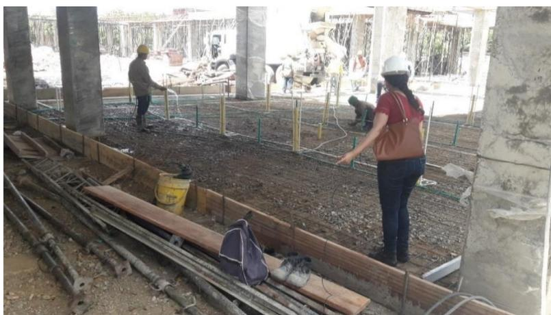
**Figura 23. Piso del Laboratorio antes de la instalación del concreto**
