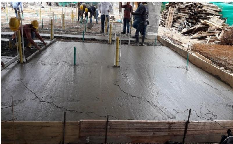
**Figura 24. Sensores instalados en el concreto**
