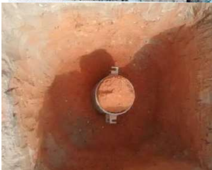
Figura 23 Toma de CBR inalterado en campo
