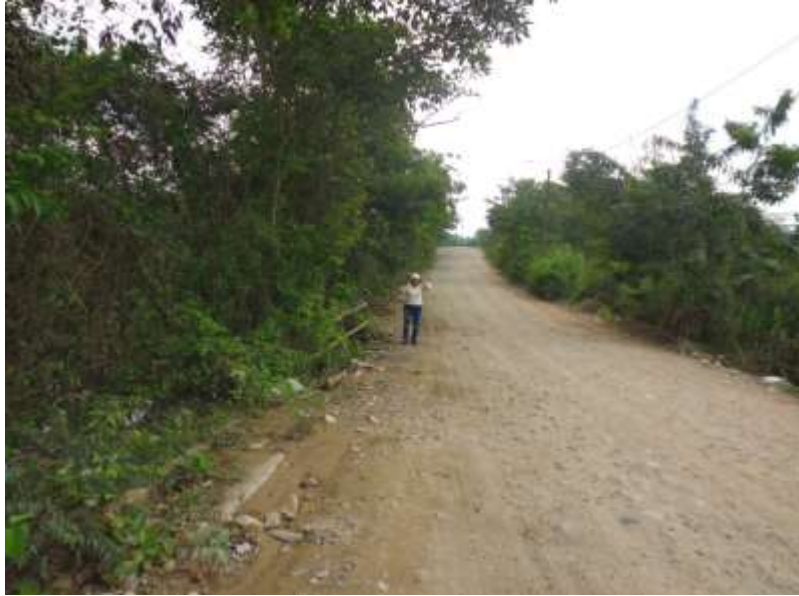
Fotografía 3. Estado de la vía tramo 2. Año 2019.
