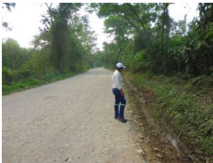
Fotografía 2. Estado de la vía tramo 1. Año 2019.
