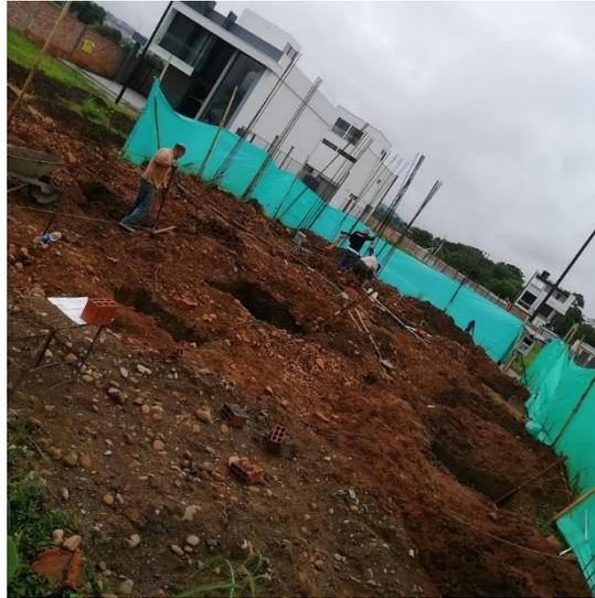
**SE REALIZO CERRAMIENTO EN TELA VERDE AL TODO EL PERÍMETRO DE LA OBRA, SE REQUIRIÓ CUBRIR UN PERÍMETRO DE 80ML, POR LO QUE SE USARON 2 ROLLOS DE 50 M X 2.10 M DE ALTO. PARA PODER COMENZAR CON EL PROCESO CONTRUCTIVO DE LAS ZAPATAS.**
