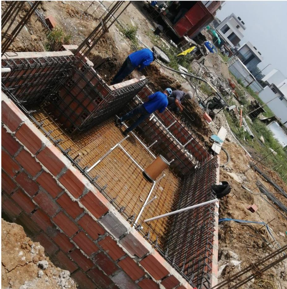
LAS ESPECIFICACIONES TÉCNICAS DE LA PISCINA COMIENZAN POR UN RECUBRIMIENTO EN MAMPOSTERIA DE BLOQUE GALLETA, PARA LA INSTALACIÓN DE LA ARMADURA EN ACERO DE LA PISCINA EN SUS MUROS Y
