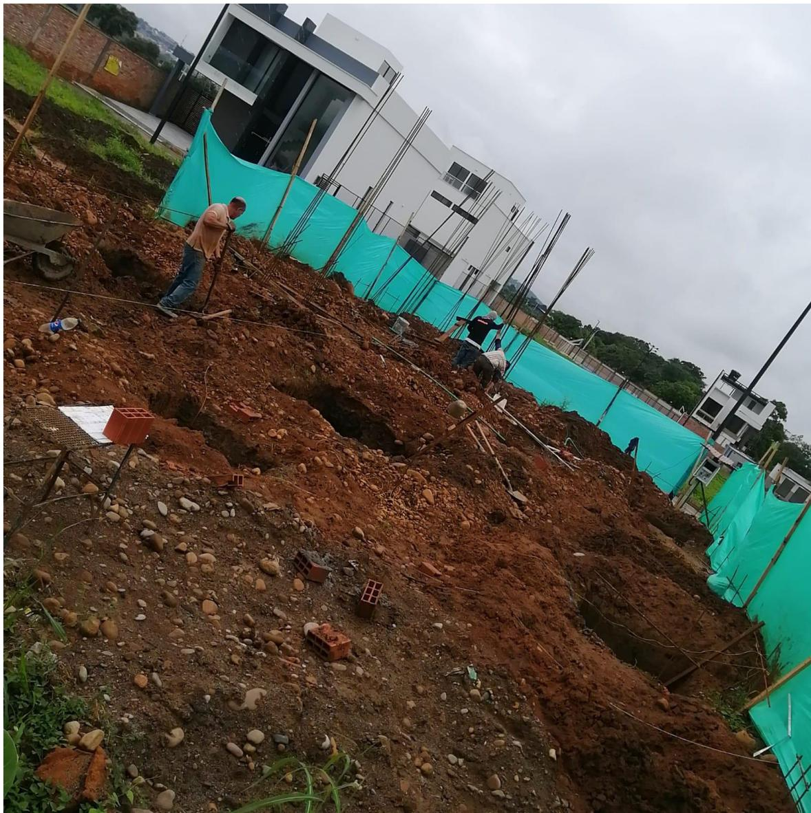
**COLOCACIÓN DE ARMADURAS ZAPATAS Y PEDESTALES. Fuente: Elaboración propia.**
