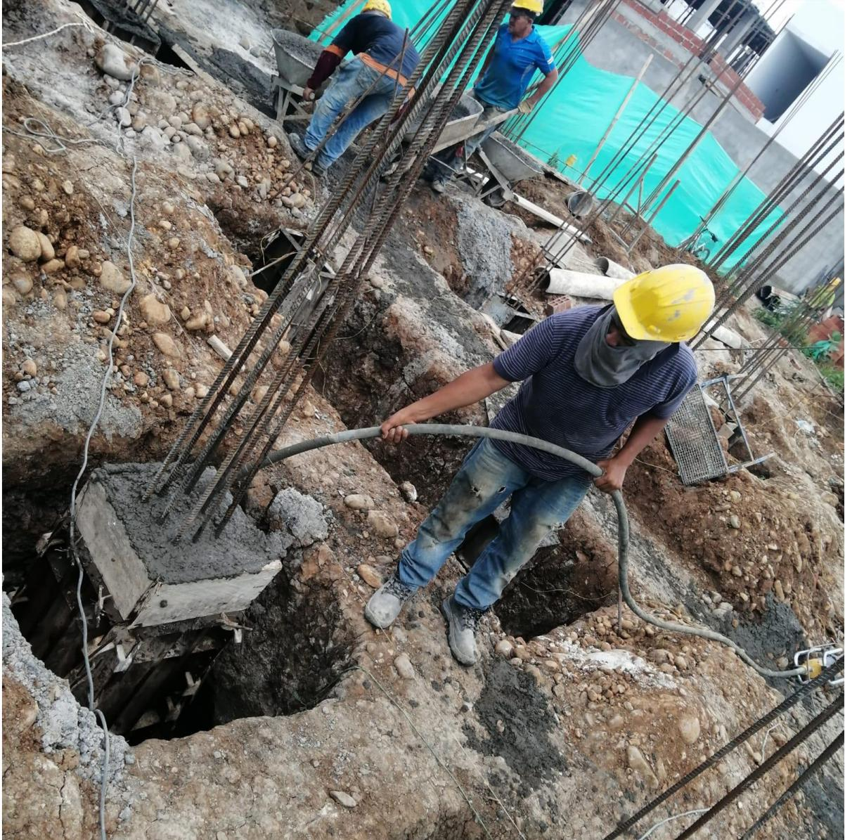
**SE FORMALETEARON LOS PEDESTALES LO CUALES CONTIENEN UN GANCHO DE .40CM DE LONGITUD, CON UNA ALTURA TOTAL DE 1.40 M Y DIMENSIONES DE DISEÑO DE (.40 X .40), (.25 X .85), (.25 X .40), (.25 X .50), RESPECTIVAMENTE SEGÚN SEA LA UBICACIÓN INDICADA POR EL DISEÑO ENTREGADO POR EL CONTRATISTA, CON 4 VARILLAS DE ½" Y ESTRIBOS DE 3/8" A .10 M CADA UNO.**
