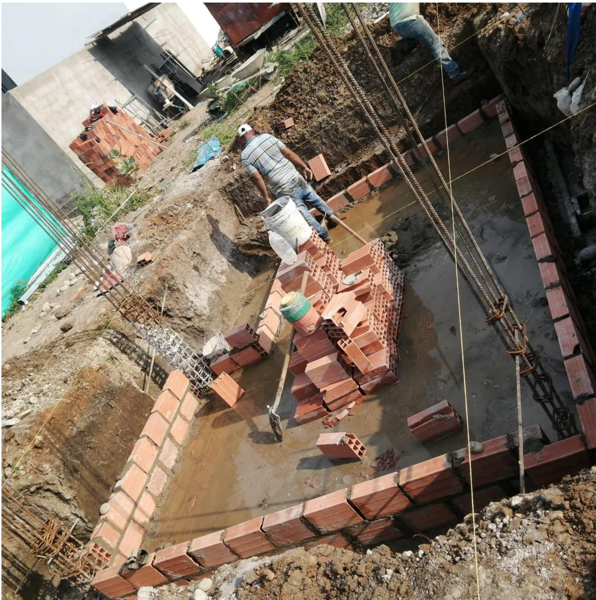
**INSTALACIÓN DE ESTRUCTURA EN ACERO PARA PISO Y MUROS DE PISCINA. Fuente: Elaboración propia.**
