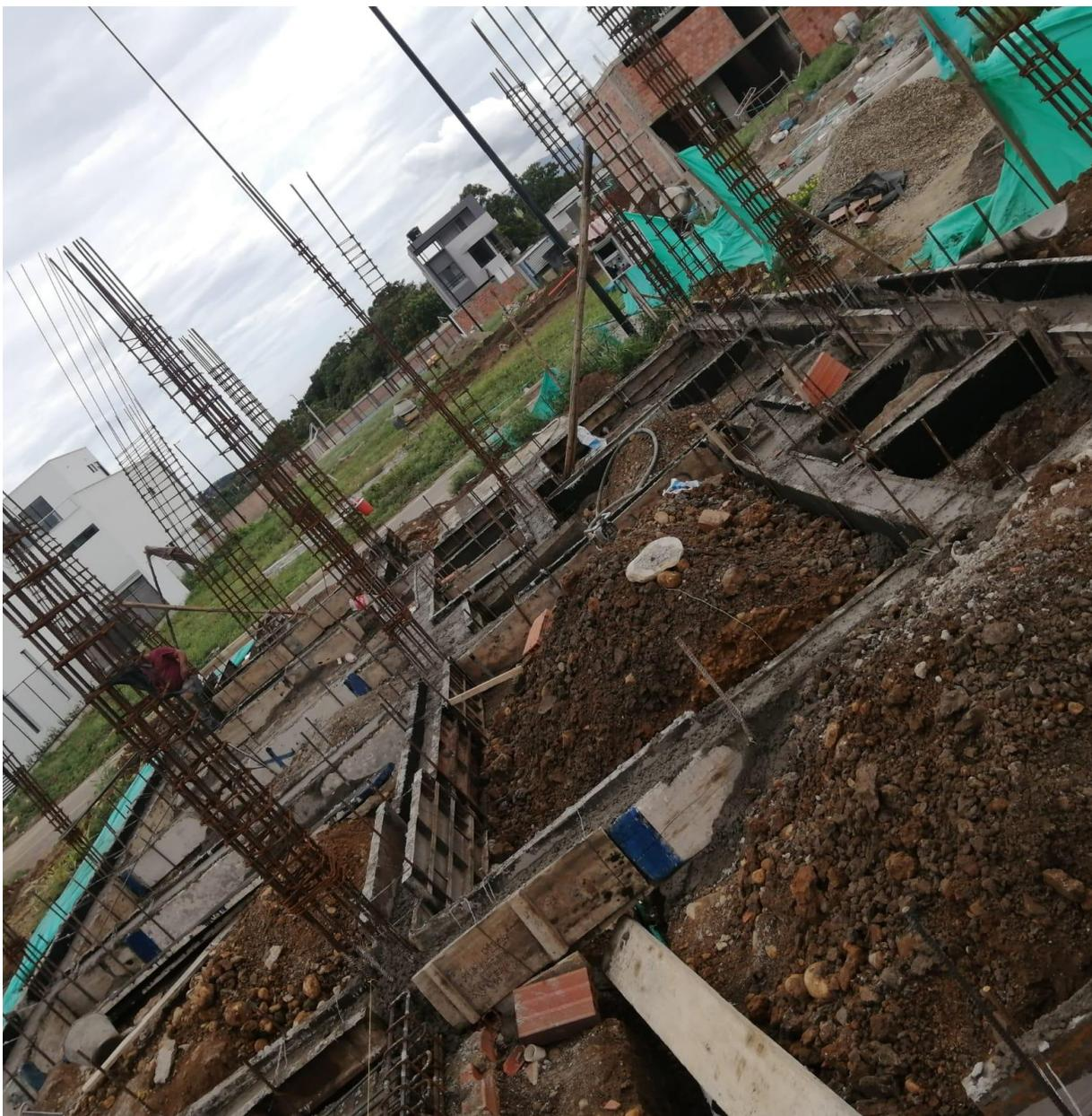
**INSTALACIÓN Y AMARRADO DE ACEROS PARA LA FUNDICIÓN DE COLUMNAS. Fuente: Elaboración propia.**
