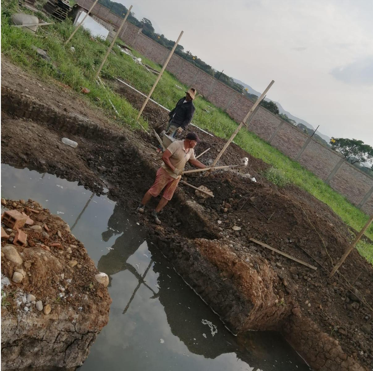
**LA EXCAVACIÓN MANUAL DE LA PISCINA SE LLEVO A CABO CON HERRAMIENTA MENORES TALES COMO PICO Y PALA PARA DEMARCAR LA ZONA PARA LA EXCAVACIÓN CON MAQUINARIA, LA CUAL TARDÓ ALREDEDOR DE 3 DÍAS.**
