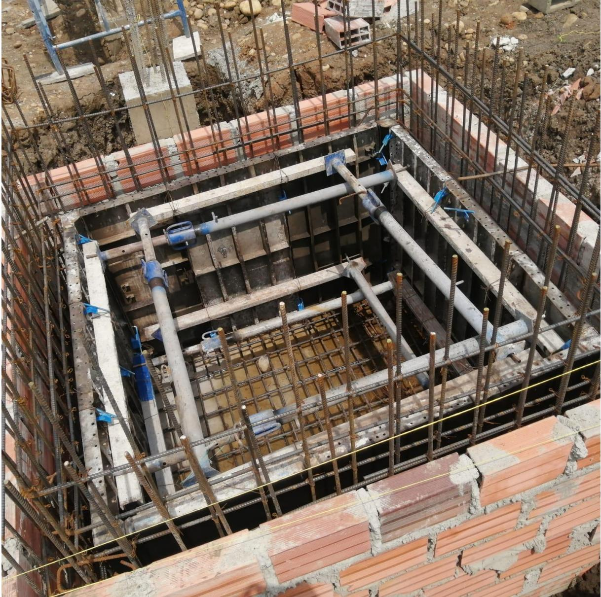
**APLICACIÓN DE ARMADURA EN ACERO Y FORMALETAS INFERIORES PARA LA FUNDICIÓN DE LA TAPA DEL TANQUE SUBTERRÁNEO. Fuente: Elaboración propia.**
