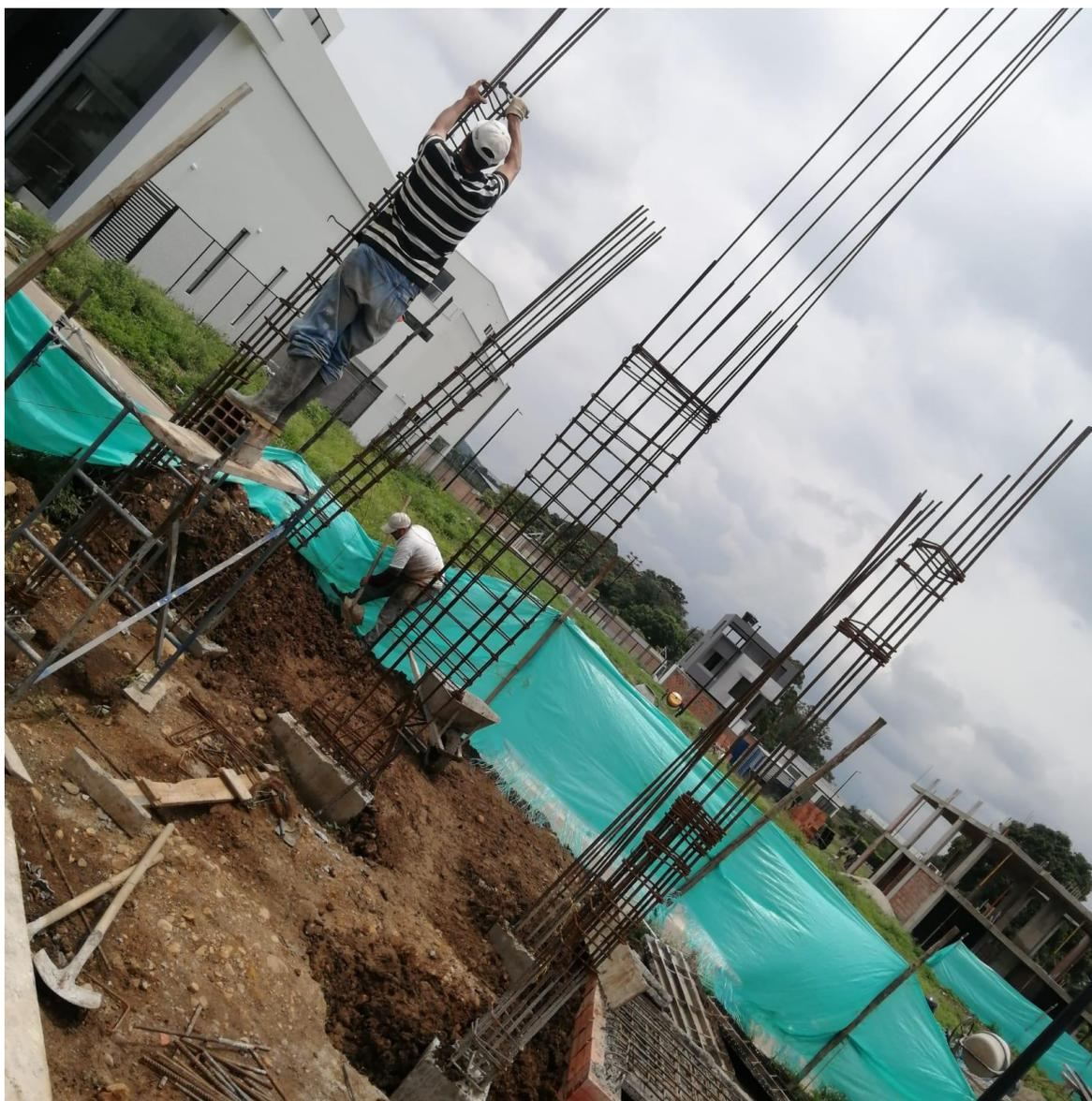
**ARMADO DE LAS COLUMNAS, AMARRADO DE ESTRIBOS PARA SU POSTERIOR PUESTA DE FORMALETA METÁLICA PARA FUNDICIÓN**
