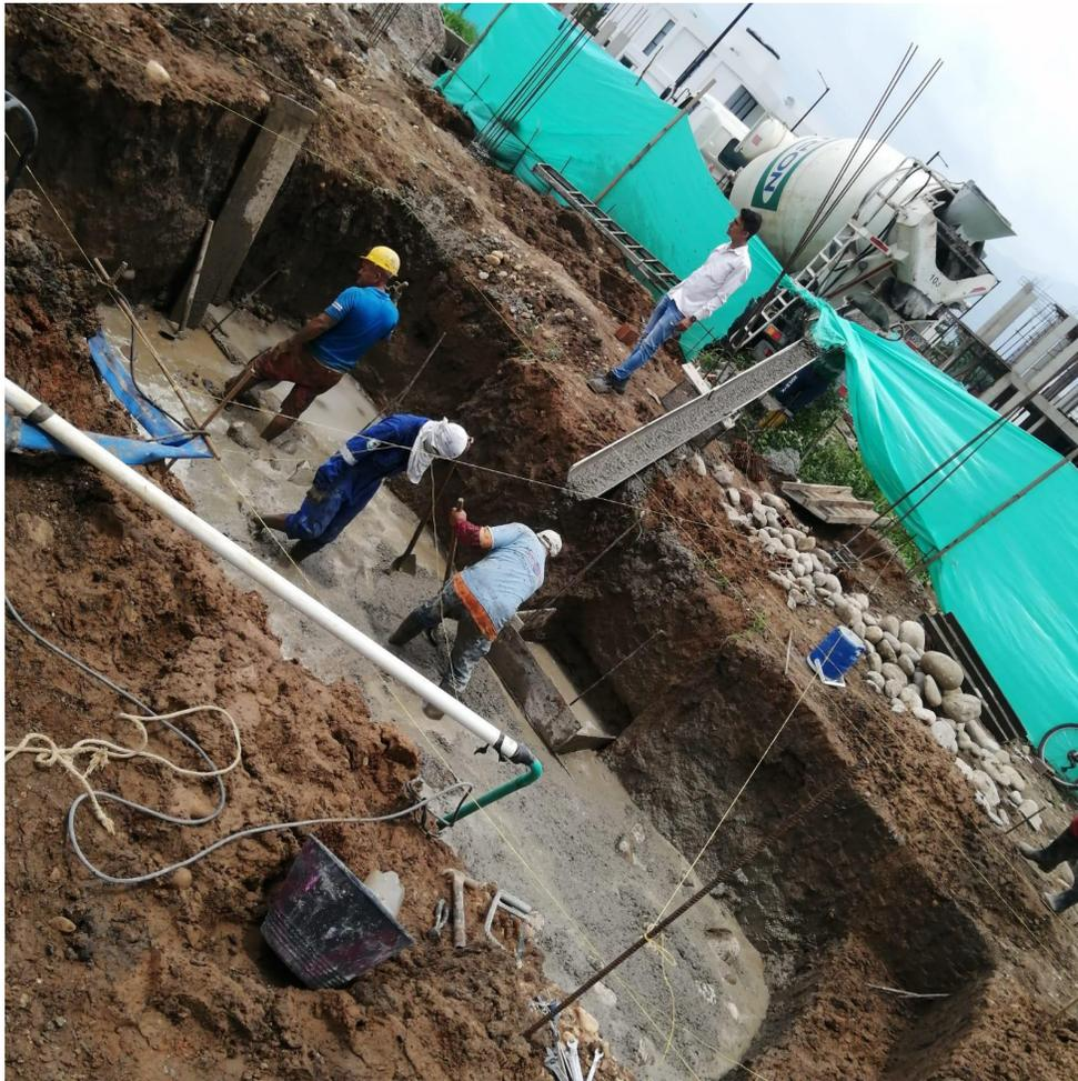
**SE PROCEDE A LA INSTALACIÓN DEL CONCRETO CICLÓPEO EN LA BASE DE LA PISCINA CON UN ESPESOR DE .30 M. CON UN CONCRETO PREMEZCLADO DE 3000 PSI OCUPANDO UN VOLUMEN DE 6 M3.**
