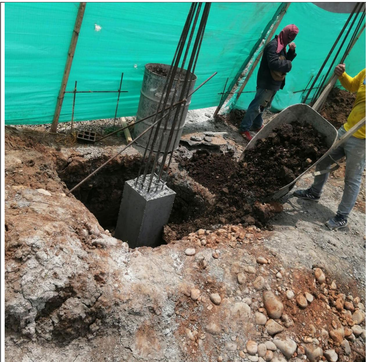
**SE PROCEDIÓ A RELLENAR LOS ESPACIOS VACIÓN ENTRE LA ZAPATA, EL PEDESTAL Y LA SUPERFICIE CON EL MISMO MATERIAL RETIRADO RESTANTE PRODUCTO DE LA PREVIA EXCAVACIÓN.**
