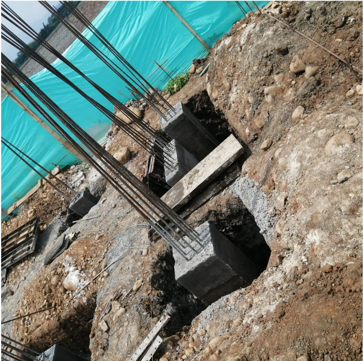
**DESPUÉS DEL TIEMPO DE SECADO SE PROCEDIÓ AL DESENCOFRADO DE FORMALETA METÁLICAA DE TODAS LAS ZAPATAS Y PEDESTALES ELABORADOS.**
