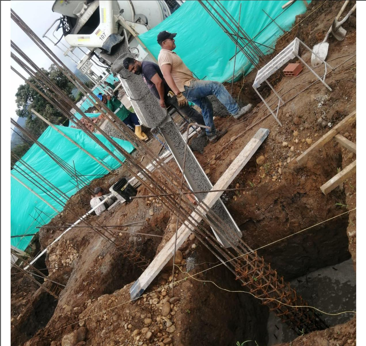
**PARA LA FUNDICIÓN DE LA ZAPATAS SE USÓ CONCRETO PREMEZCLADO “MIXEL” DE 3000 PSI; OCUPANDO ENTRE TODO UN VOLUMEN DE 7,739 M3.**
