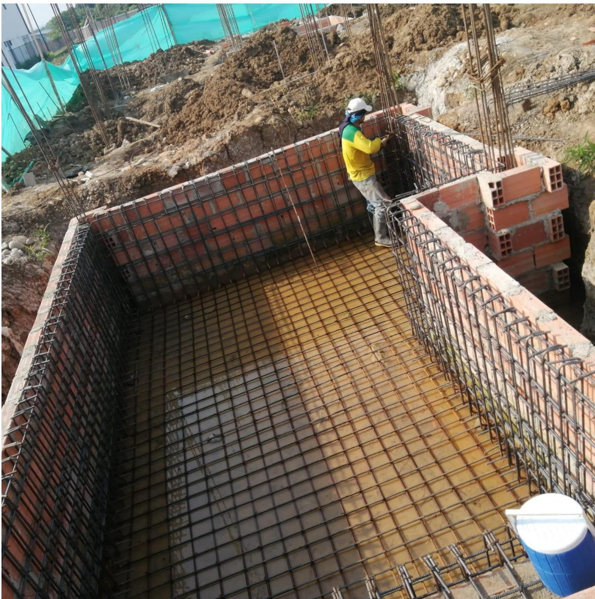
**INSTALACIÓN DE TUBERÍA Y FORMALETA PARA LA FUNDICIÓN DE EL PISO Y MUROS DE LA PISCINA. Fuente: Elaboración propia.**
