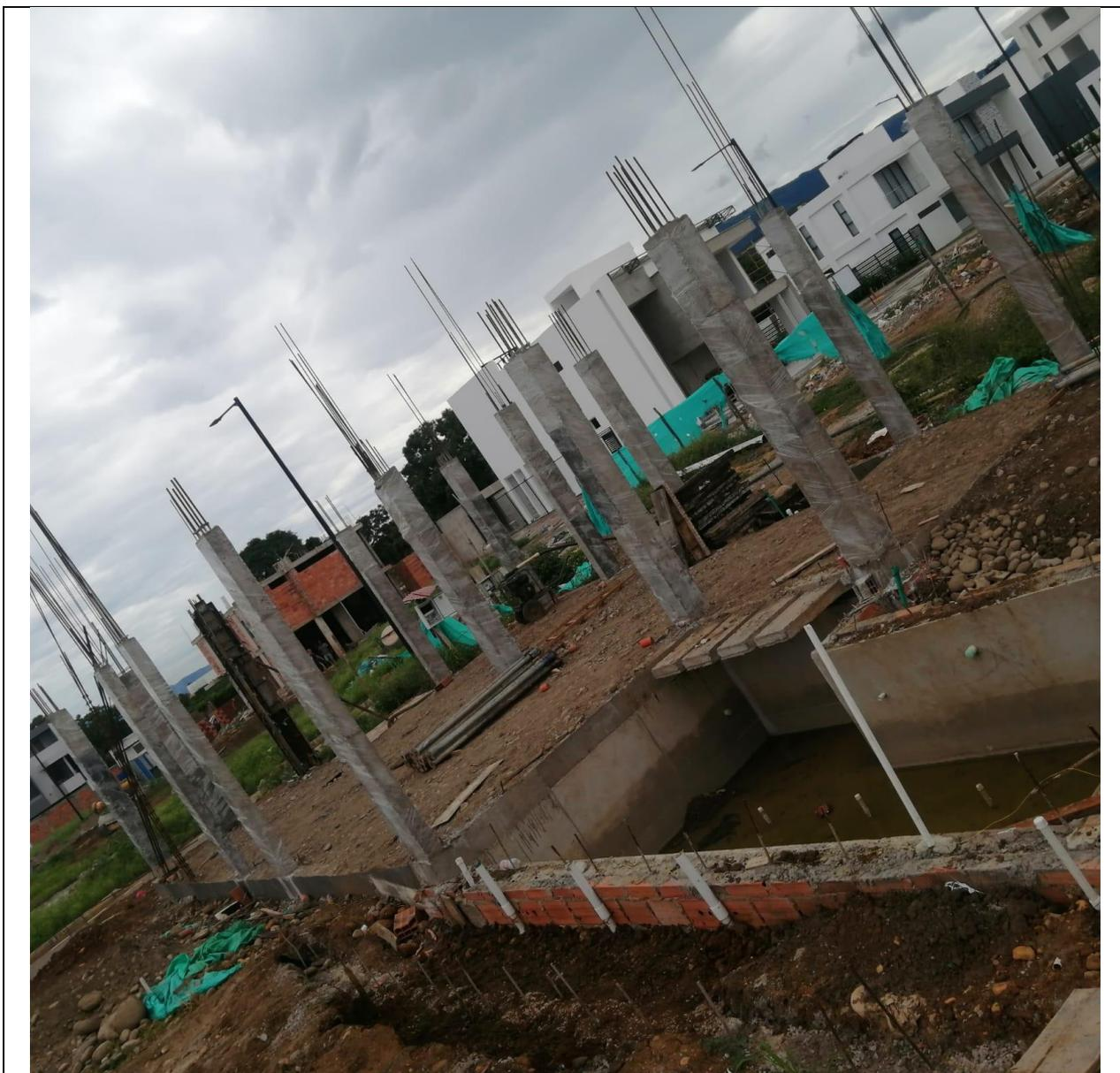
**FUÉ UN ÉXITO LA FUNDICIÓN DE LAS COLUMNAS DESPUES DEL DESENCOFRADO NO SE ENCONTRÓ PROBLEMA ALGUNO, PUES SE SIGUIERON AL PIE TODOS LOS DISEÑOS ENTREGADOS POR EL CONTRATISTA ANALIZANDOLOS Y SUPERVISANDOLOS EN EL MOMENTO DE SU IMPLEMENTACIÓN EN EL CAMPO DE TRABAJO.**
