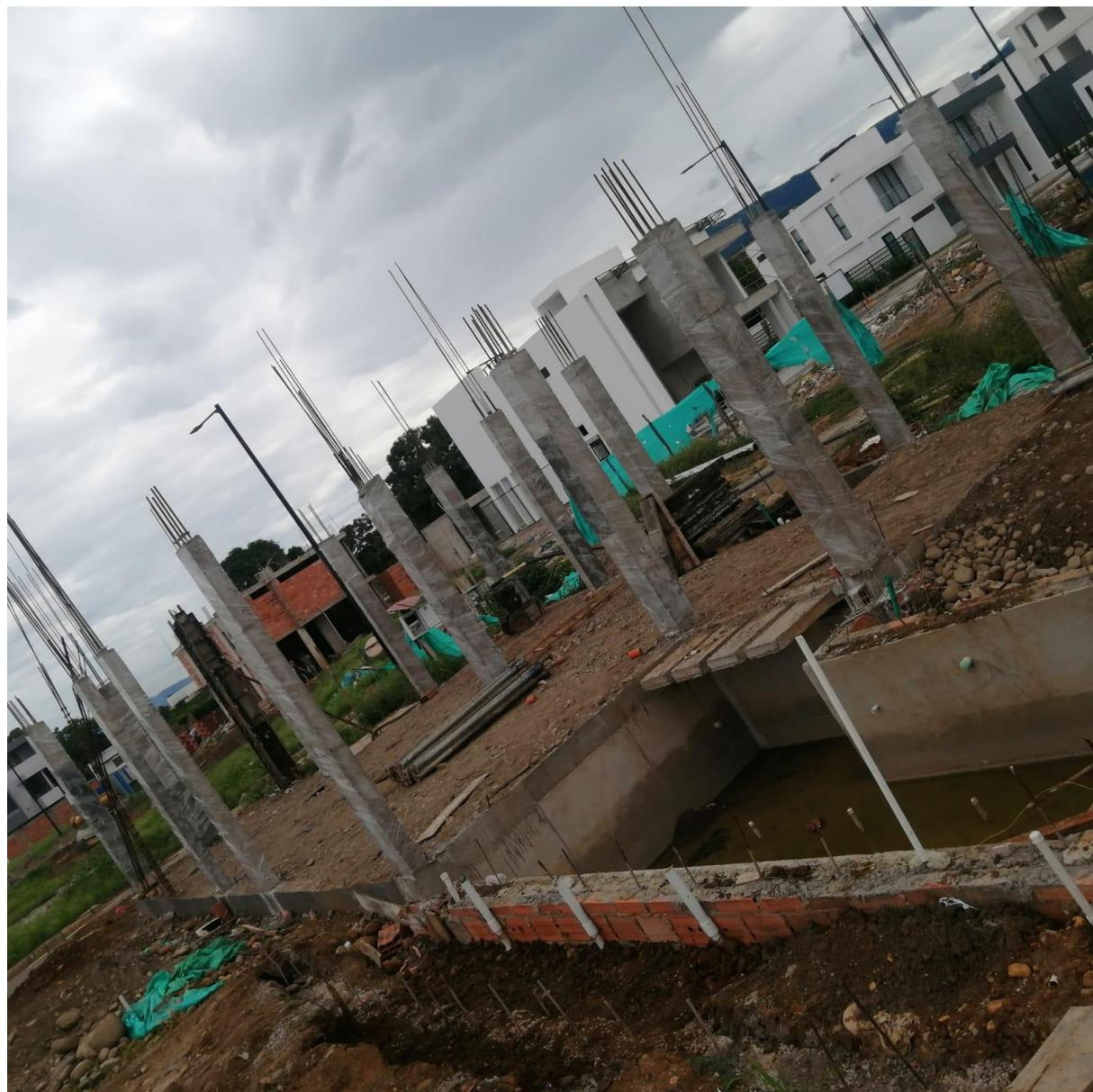
**CONSTRUCCIÓN, MAMPOSTERIA, ACERO Y FORMALETEADO PARA LA FUNDICIÓN DEL TANQUE SUBTERRÁNEO. Fuente: Elaboración propia.**
