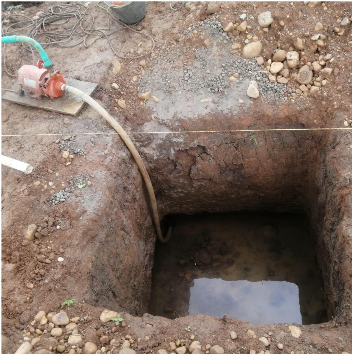
**EXCAVACIÓN ZAPATAS (ZAPATAS EXCAVADAS MANUALMENTE). Fuente: Elaboración propia.**
