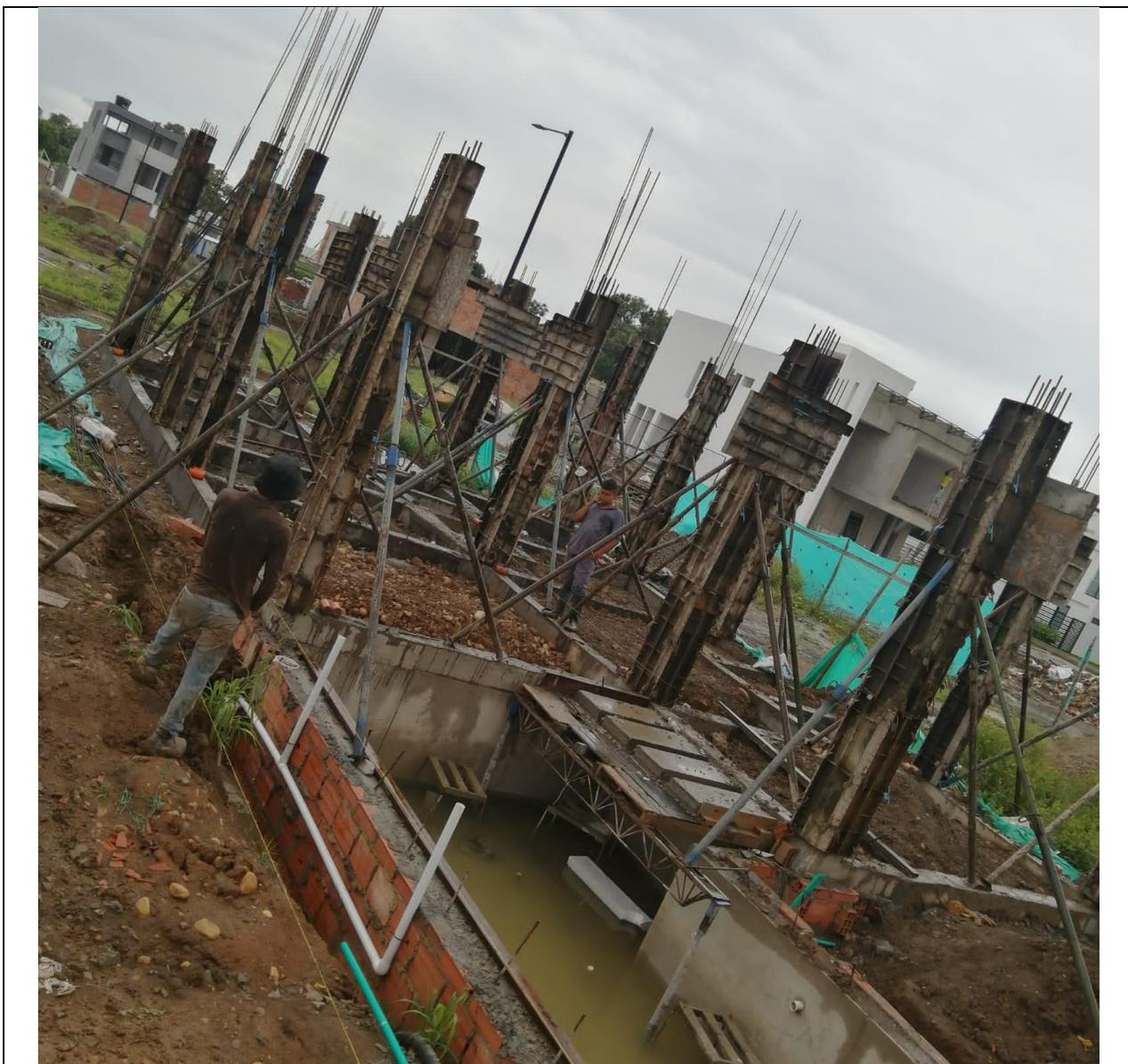
**SE PROCEDIÓ A LA INSTALACIÓN DE LAS FORMALETAS CON SUS RESPECTIVOS PARALES QUE GARANTICEN LA FORMA FINAL DEL DISEÑO ESTRUCTURAL ENTREGADO POR EL CONTRATISTA**
