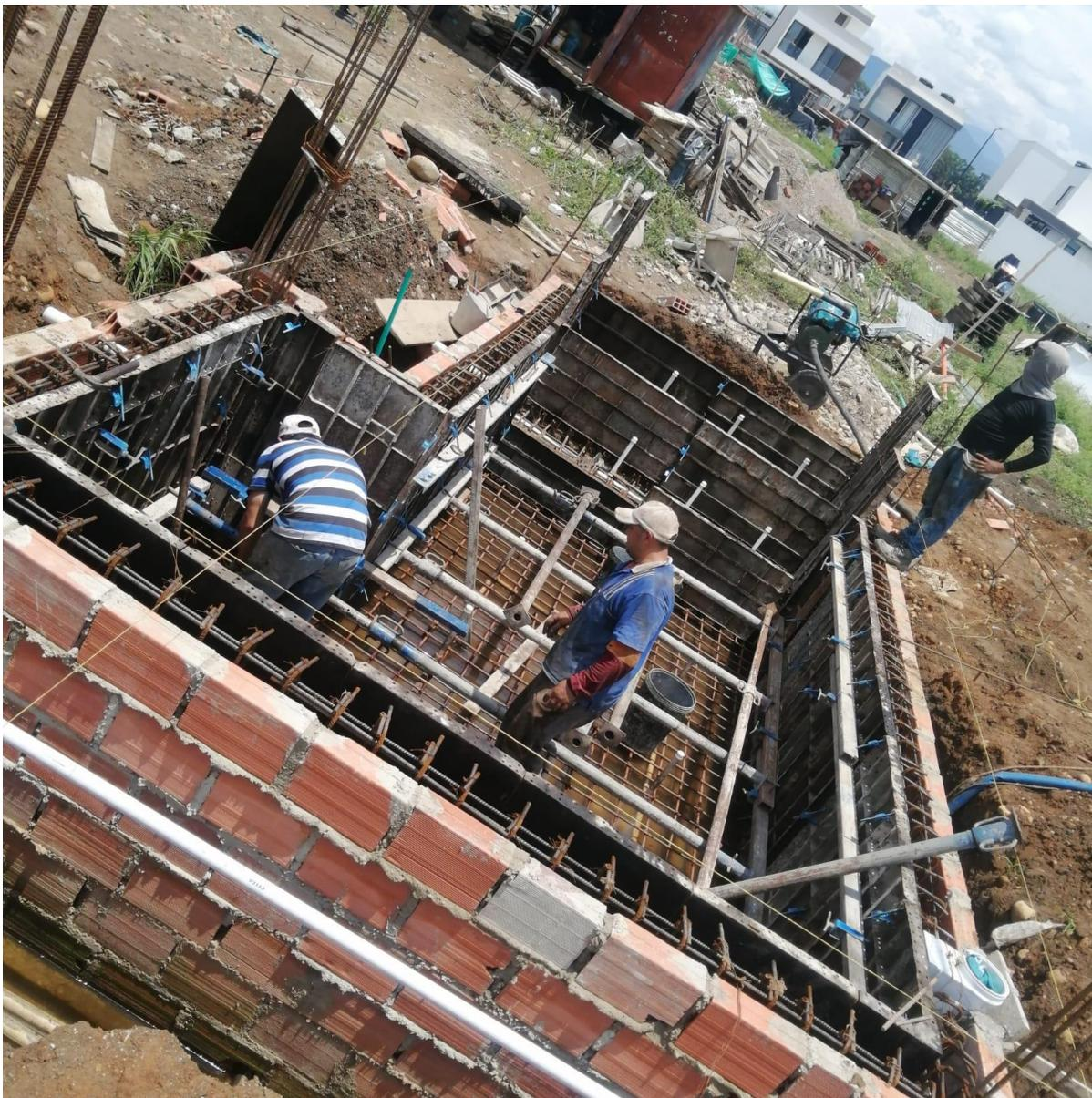
**ENCOFRADO Y FUNDICIÓN VIGAS DE CIMENTACIÓN. Fuente: Elaboración propia.**
