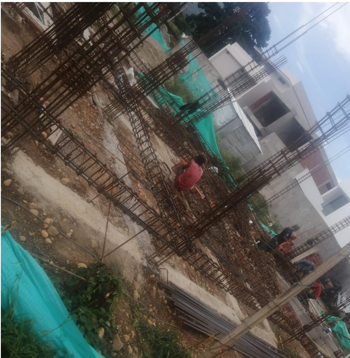
**INSTALACIÓN DE FORMALETA PARA FUNDICIÓN DE COLUMNAS. Fuente: Elaboración propia.**
