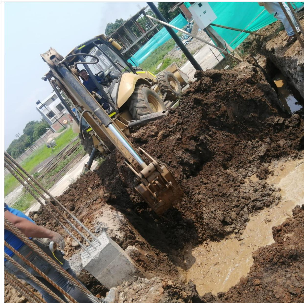
**EL MISMO DÍA QUE SE REALIZÓ LA EXCAVACIÓN CON LA RETROEXCAVADORA DE LA PISCINA SE CONTINUÓ CON LA EXCAVACIÓN DEL TANQUE SUBTERRÁNEO DE 2.50 X 2.50 M Y CON UNA PROFUNDIDAD DE 1.70 M.**
