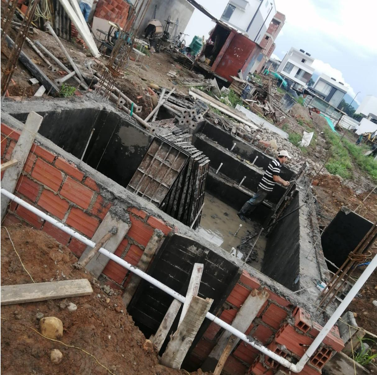
**SE PROCEDIÓ A IMPLEMENTAR LAS FORMALETAS METÁLICAS PARA LA FUNDICIÓN CON CONCRETO PREFABRICADO DE 3000 PSI CON UN SELLO DE SIKAFLEX PRO 3WF + SIKADUR 32, DESPUÉS DEL SECADO SE PROCEDIÓ AL RETIRADO DE LA FORMALETAS METÁLICAS PARA DEJAR AL DESCUBIERTO EL RESULTADO DE LA FUNDICIÓN DEL PISO Y MUROS DE LA PISCINA.**
