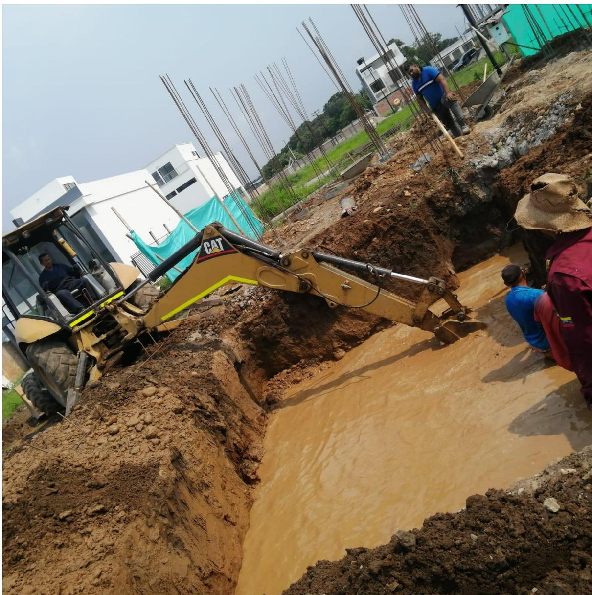
**PARA LA EXCAVACIÓN MECÁNICA SE IMPLEMENTO MAQUINARIA PESADA, EN ESTE CASO UNA RETROEXCAVADORA CARGADORA CATERPILLAR 416 F2, EN EL ÁREA DE LA PISCINA HASTA LAS MEDIDAS DE LOS DISEÑOS LOS CUALES INDICABAN UNA PROFUNDIDAD DE 1.7 M Y UN ÁREA TOTAL DE 21 M2.**
