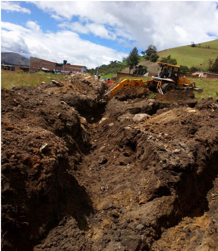
Figura 18. Foto donde se observa trazado red alcantarillado, con retroexcavadora
