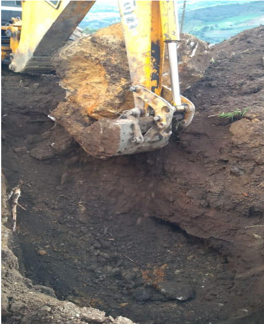
Figura 3. Foto donde se observa retiro de roca con la retroexcavadora
