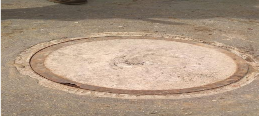
Figura 16. Fotos donde se observa la tapa del alcantarillado del pozo de Inspección sobre la vía principal
