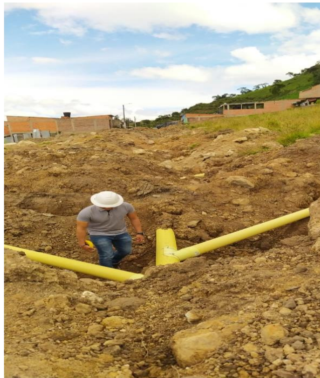
Figura 21. Foto donde se observa el relleno de las acometidas
