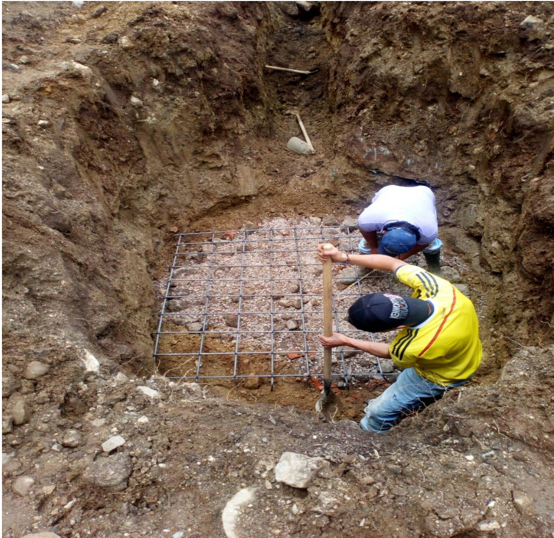
Figura 9. Foto donde se observa la construcción de 2 zapatas de dimensiones 2\text{m} * 2\text{m} * 0,1 para pozos de inspección
