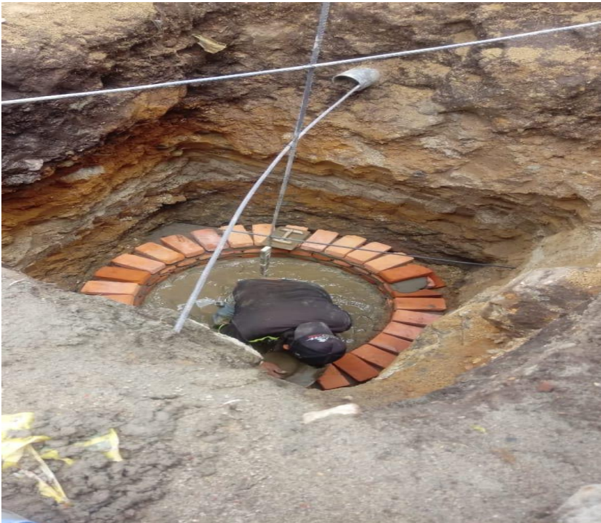
Figura 10. Foto donde se observa la instalación de concreto cañuela.
