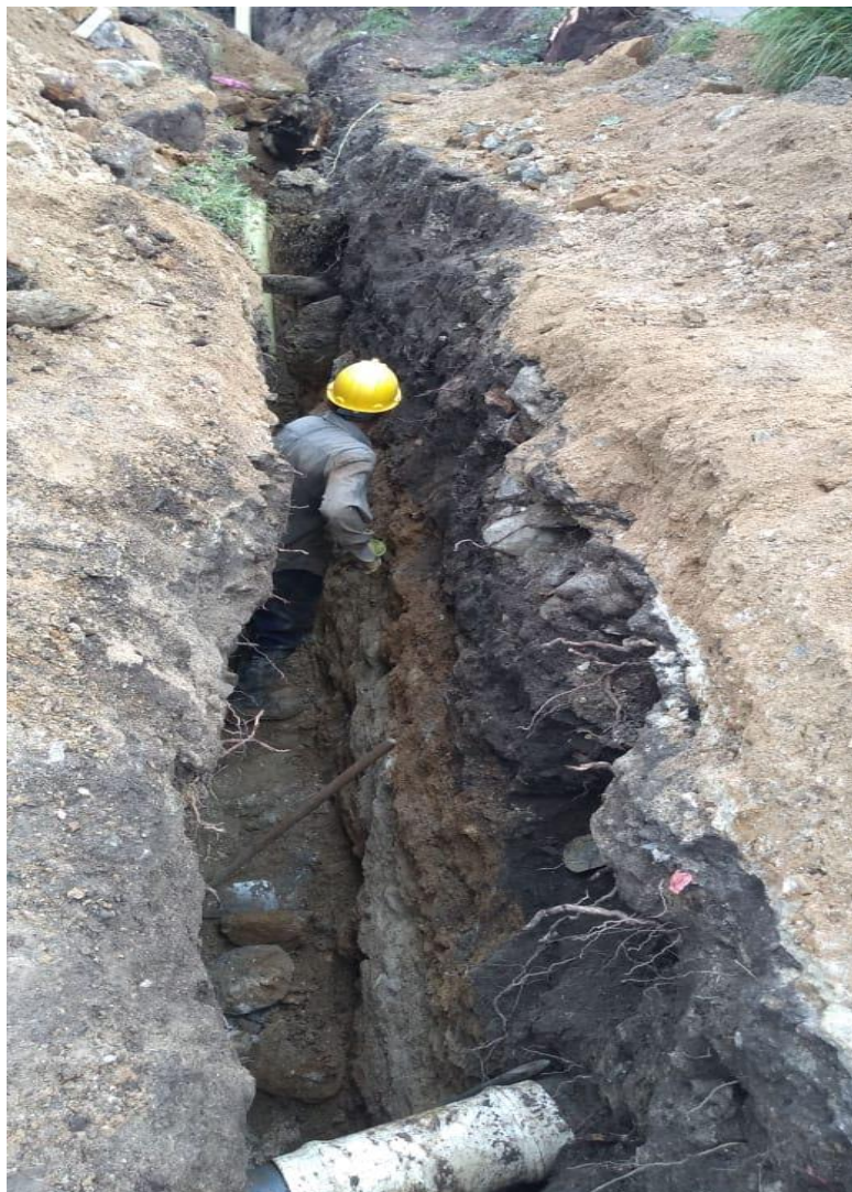
Figura 4. Foto donde se observa instalación de tubería corrugada de 8”
