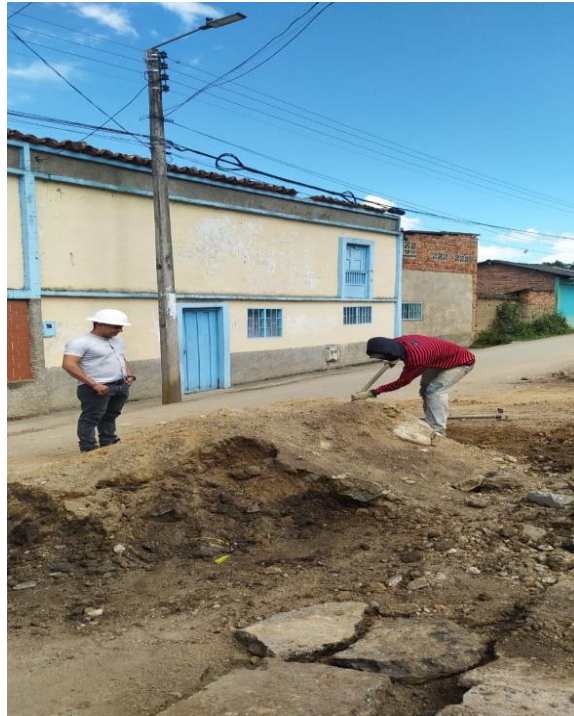
Figura 22. Foto donde se observa el relleno de la red de acueducto
