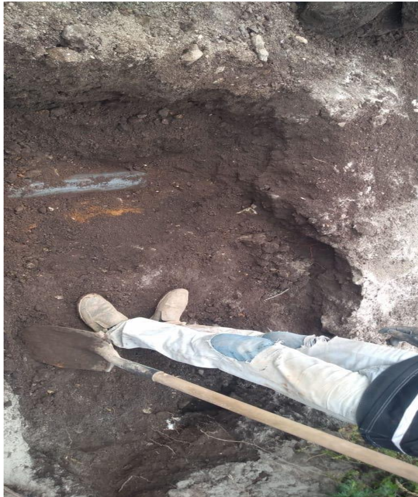
Figura 24. Foto donde se observa que en la excavación de la red de acueducto
