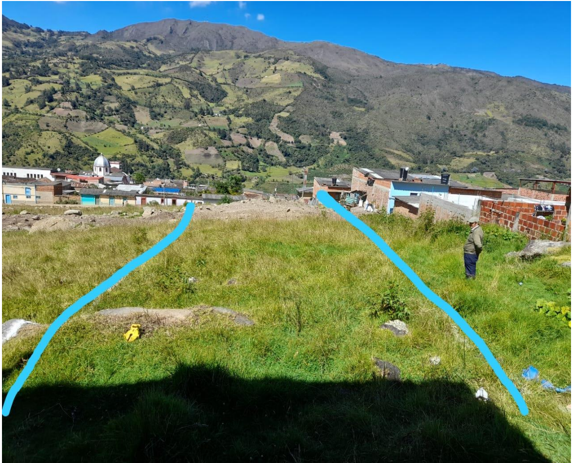
Figura 33. Foto donde se observa la marcación y nivelación del lote 2
