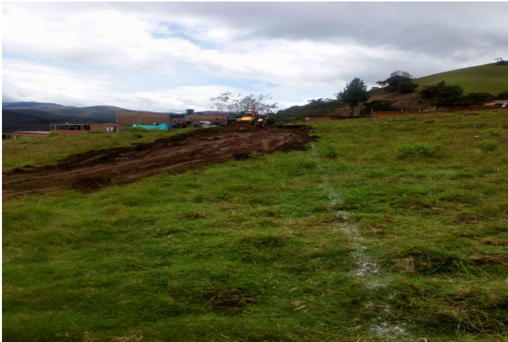
Figura 29. Foto donde se observa apertura para la pavimentación
