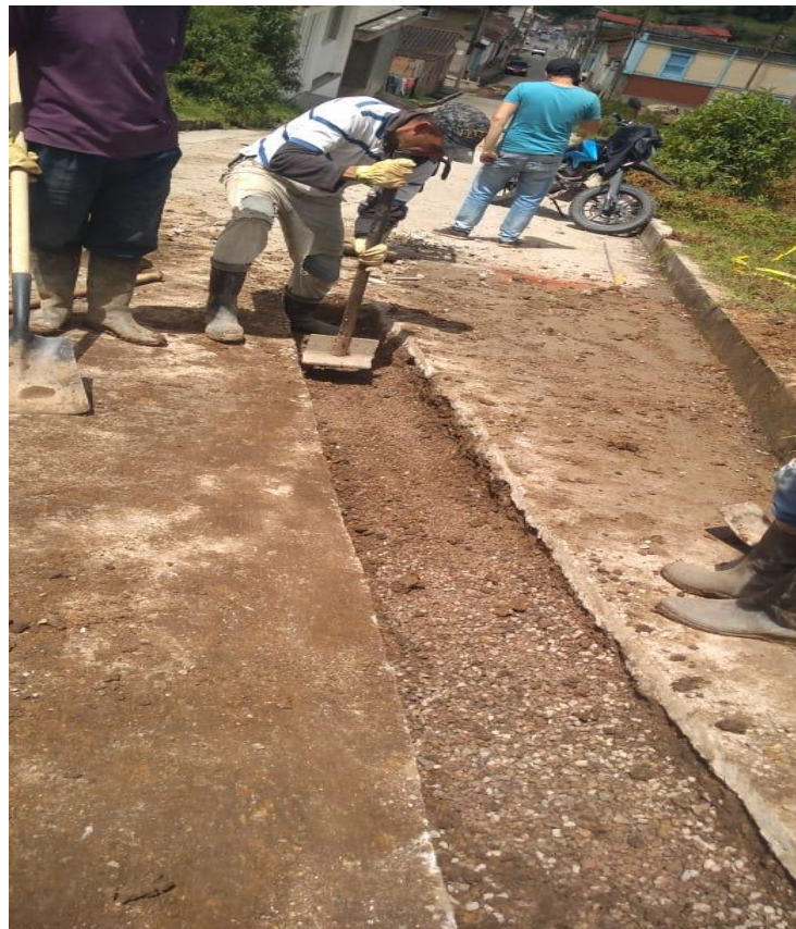
Figura 17. Foto donde se observa el auxiliar compactando con el pison
