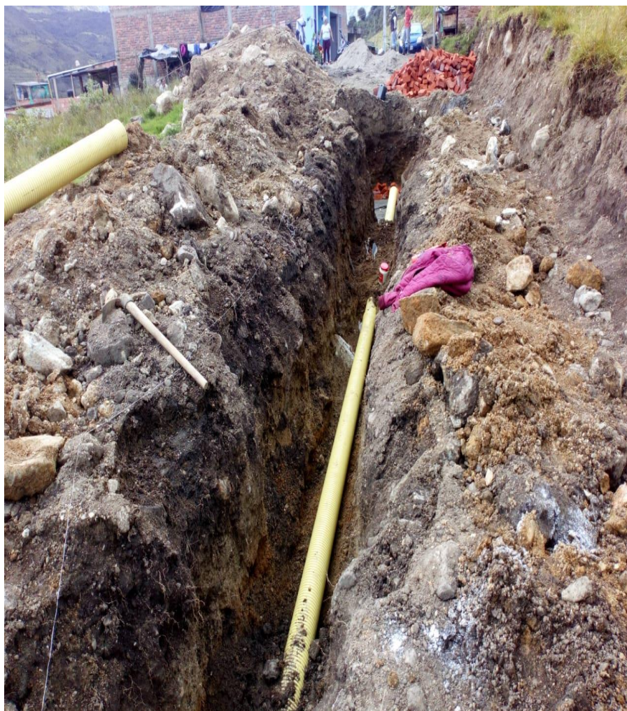
Figura 5. Foto donde se observa instalación de tubo 8" colector principal.
