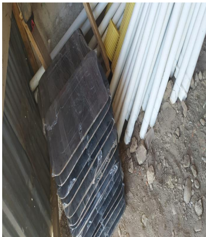
Figura 28. Foto donde se observa las tapas de la llave de paso de cada vivienda
