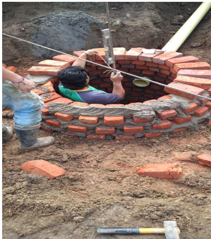
Figura 13. Foto donde observa como el oficial hace el alineamiento del bloque
