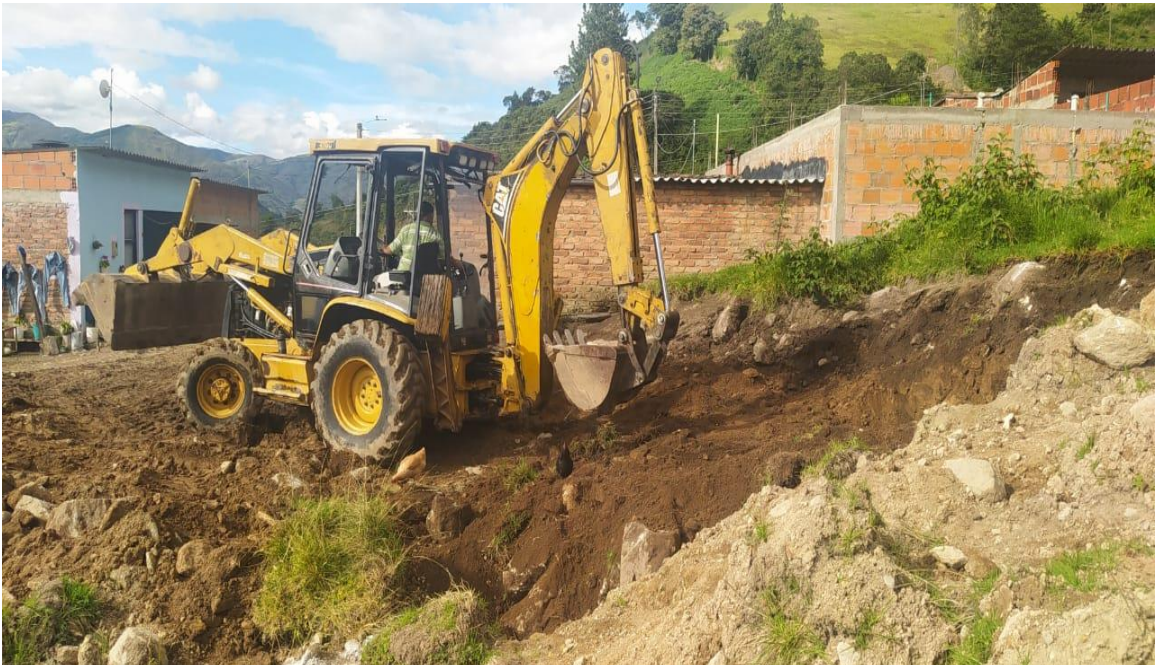
Figura 34. Fotografía donde se observa como la maquinaria retira material para la nivelación
