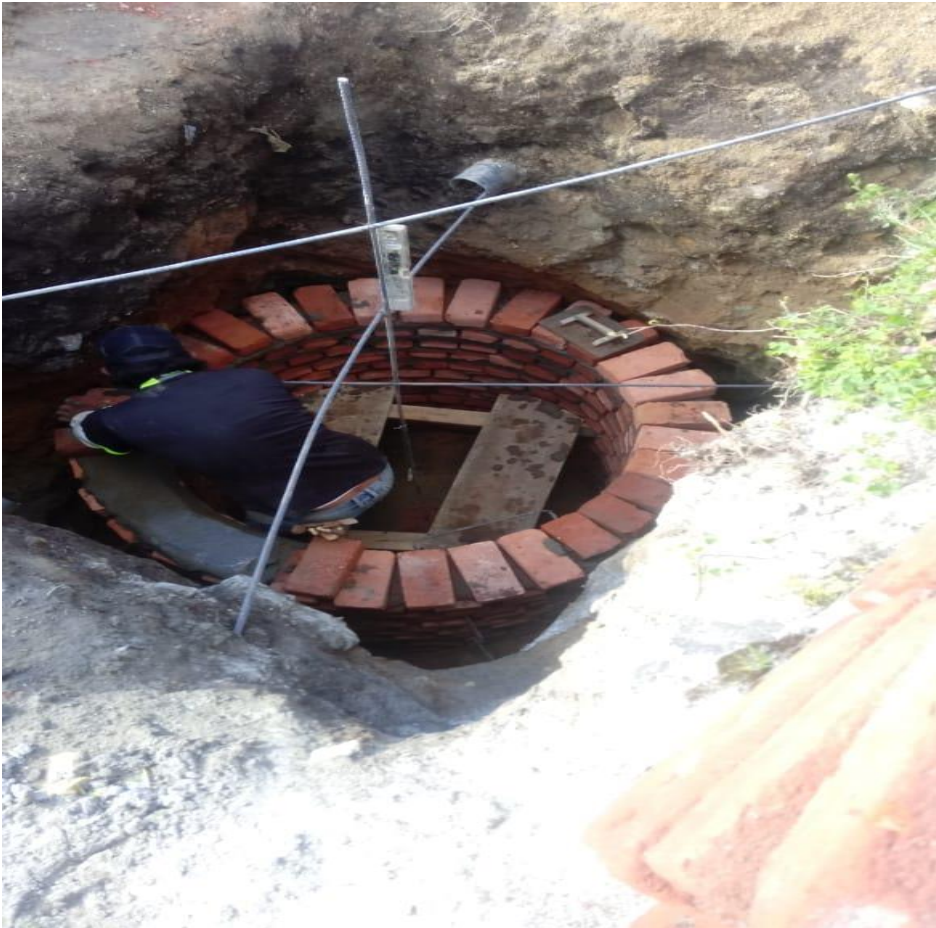
Figura 11. Foto donde se observa mampostería ladrillo tolete y mortero de Espesor .1cm
