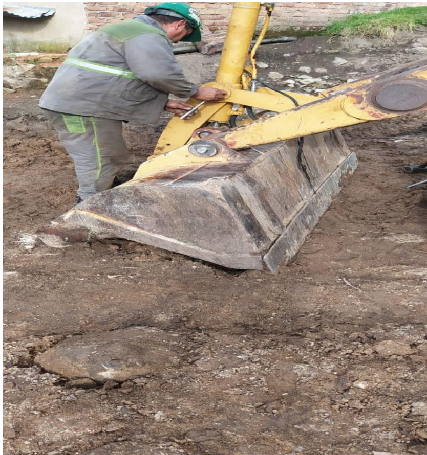
Figura 35. Foto donde se observa el cambio de los bujes de la pala de la Retroexcavadora.
