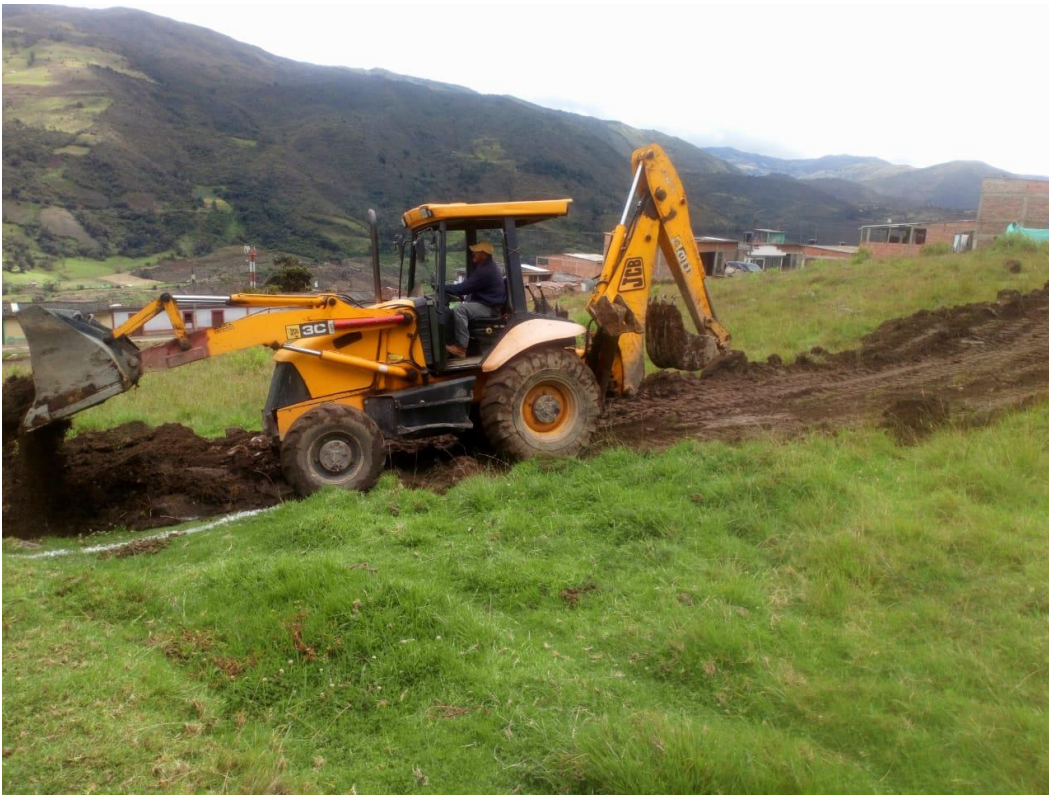
Figura 30. Foto donde se observa movimiento de tierra con maquinaria tipo Retroexcavadora.
