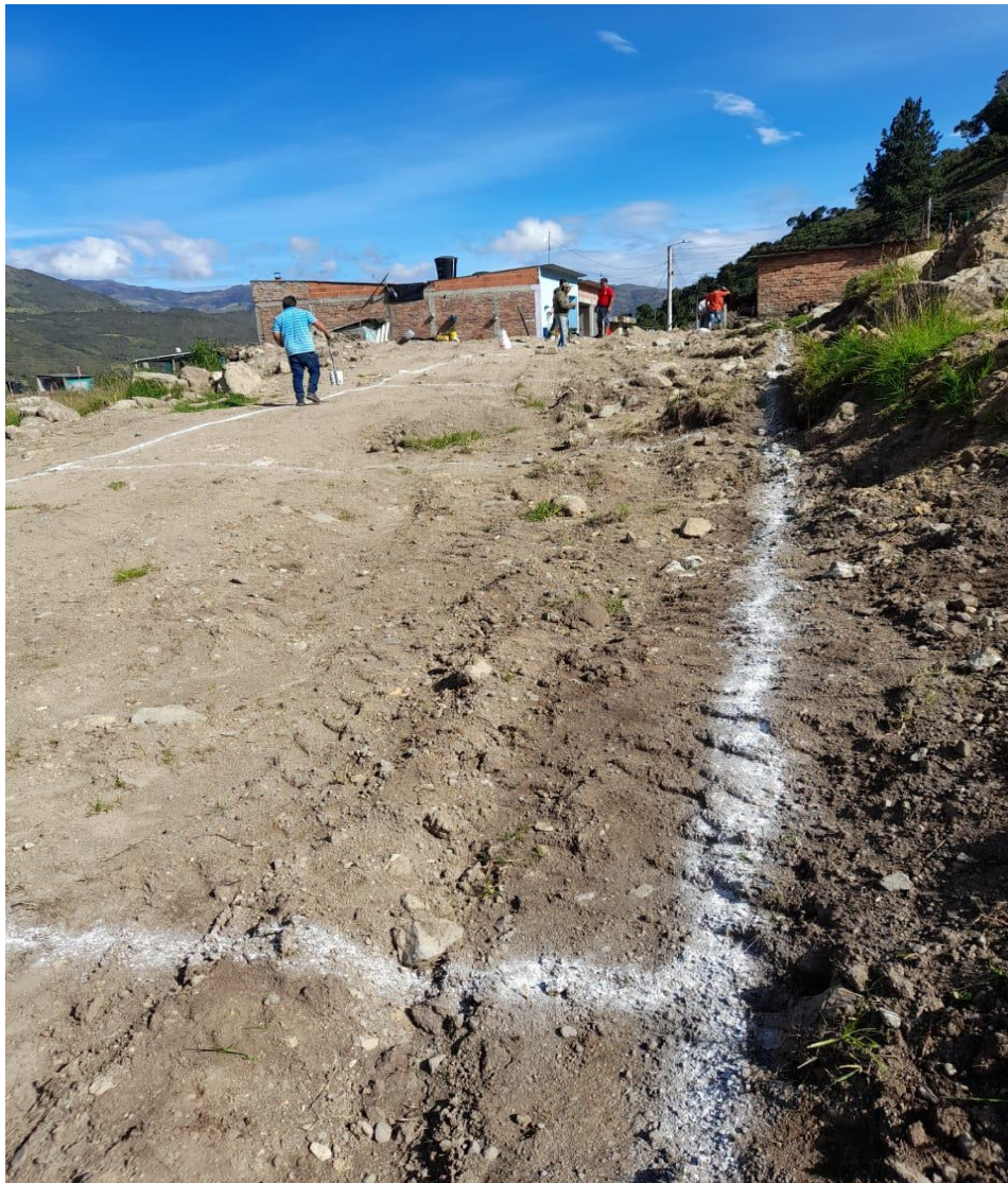
Figura 31. Foto donde se observa la marcación del terreno con cal
