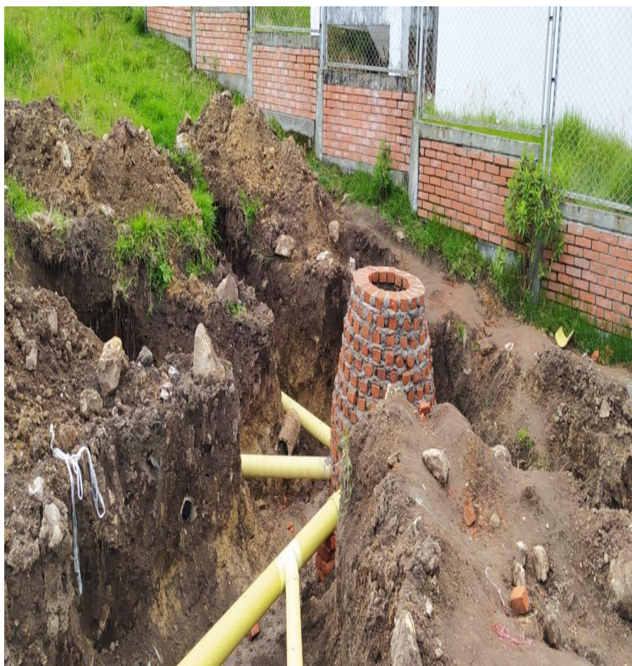
Figura 20. Foto donde se observa cómo se realizan trabajos instalación de Colectores domiciliarios red alcantarillado.
