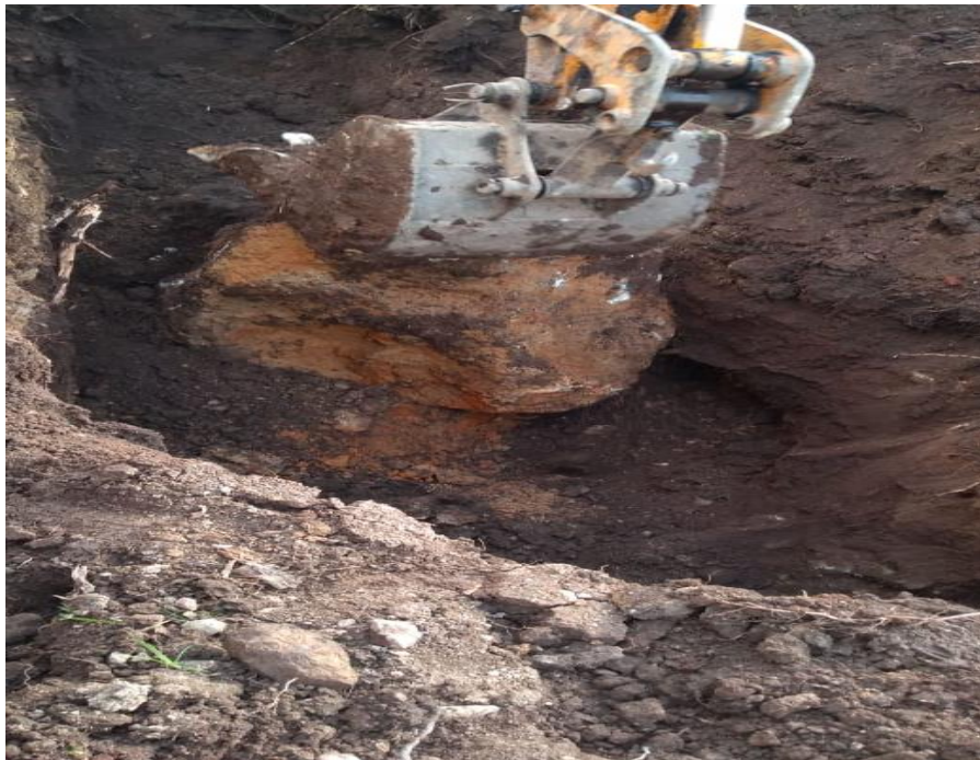
Figura 2. Foto donde se observa excavación mecánica
