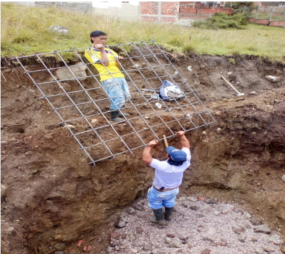
Figura 8. Foto donde se observa la colocación de la parrilla al pozo de Inspección
