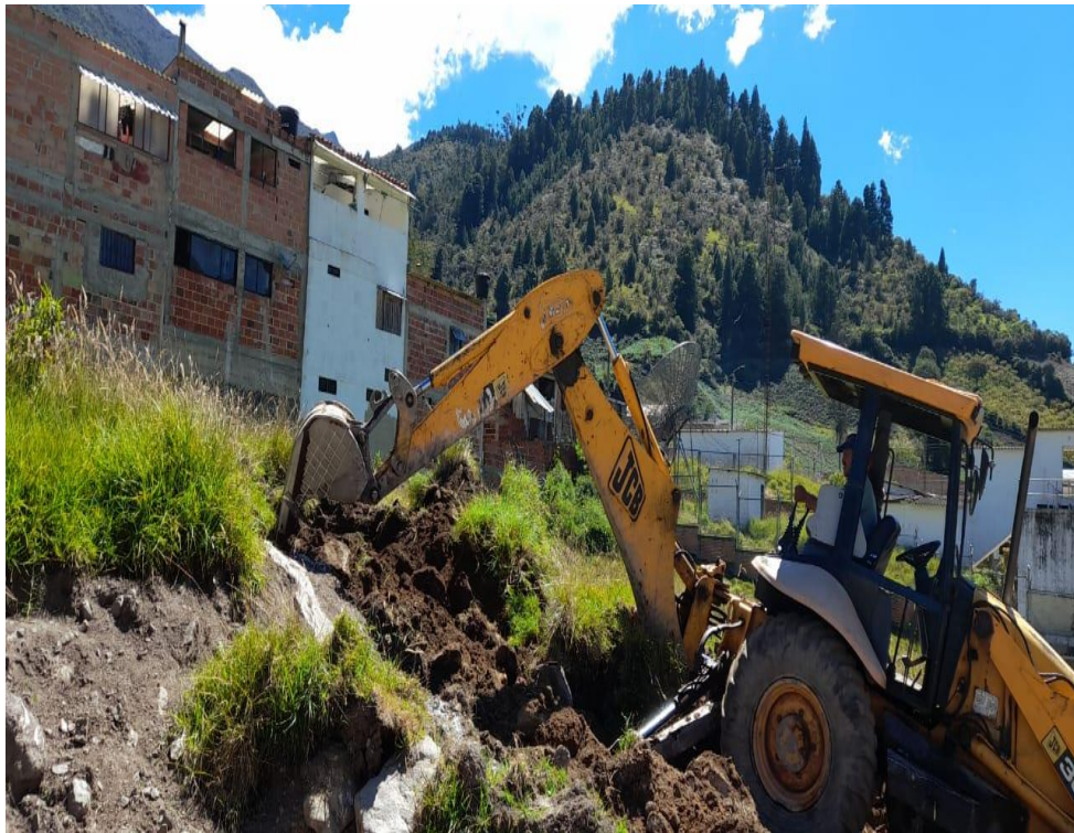
Figura 32. Foto donde se observa excavación con maquinaria tipo Retroexcavadora.
