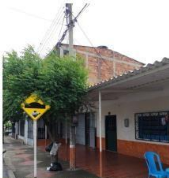
Ilustración 3. Ubicación del poste de energía eléctrica incumpliendo la distancia mínima de seguridad
