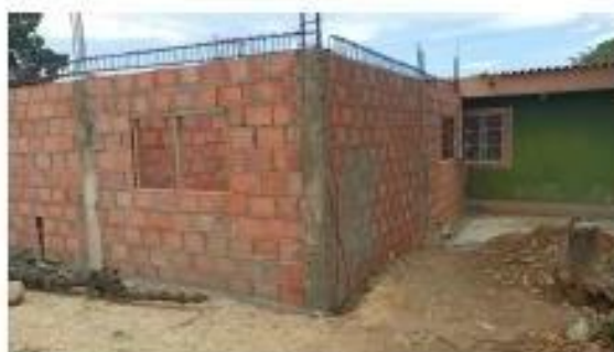
Ilustración 3. Fachada lateral en sentido avenida 1.
