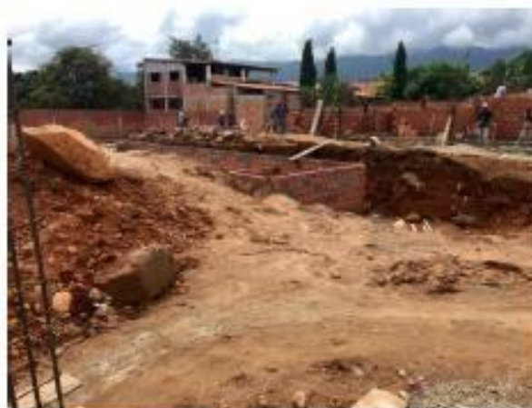
Ilustración 3. se observa la excavación y levantamiento del cerramiento en bloque no. 4.
