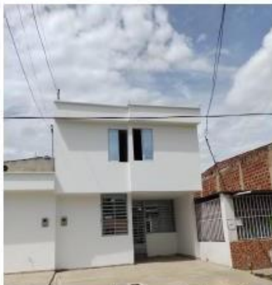
Ilustración 1. Vista de la fachada del predio donde no se evidencia ubicación de poste de energía.
