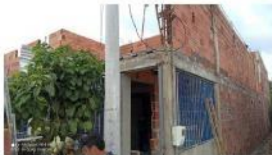
Ilustración 1. Construcción modalidad ampliación.
