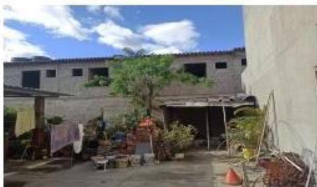
Ilustración 1. se observa la construcción de un conjunto.
