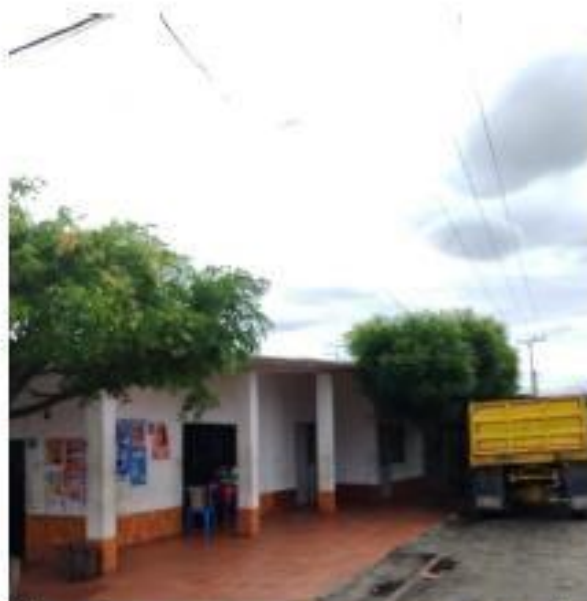
Ilustración 2. Vista sobre la calle 19 donde se observa las redes de baja tensión
