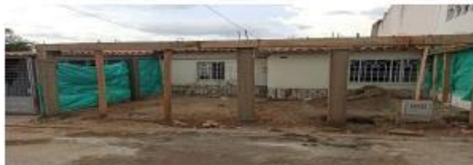
Ilustración 1. Se observa una obra modalidad cerramiento.
