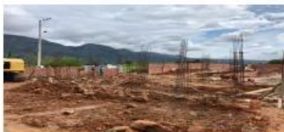
Ilustración 2. se observa una obra modalidad obra nueva.
