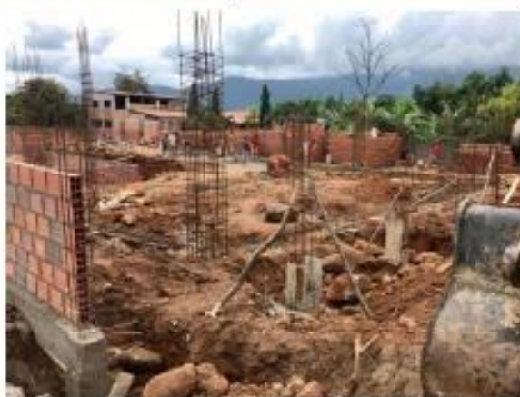
Ilustración 4. Se observa viga de amarre en concreto reforzado con sus correspondientes arranques para posteriormente fundir columnas.
