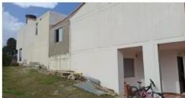
Ilustración 3. Ventana que aparentemente no está permitida en los estatutos.
