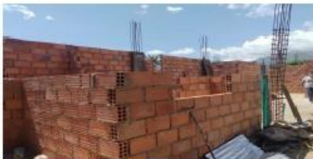
Ilustración 2. Se observa muros levantados.
