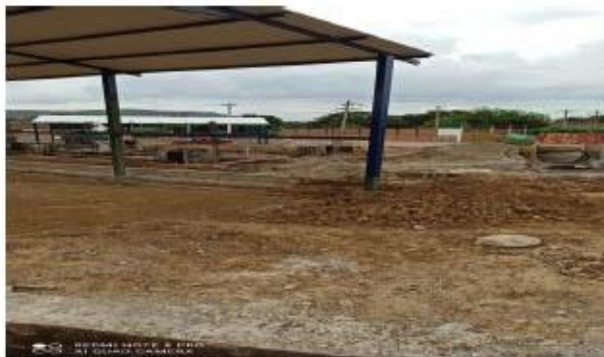
Ilustración 1. Construcción modalidad obra nueva
