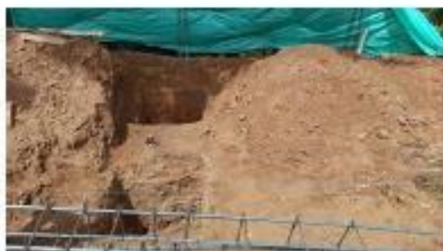
Ilustración 1. Se observa una construcción modalidad obra nueva.
