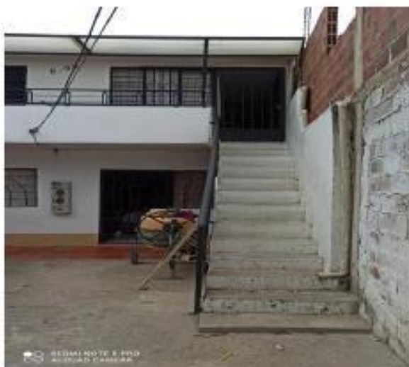
Ilustración 2. calle 30A #6-40 PATIO CENTRO.
