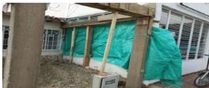
Ilustración 2. Se observa material pétreo en el ante jardín, columnas en concreto reforzado.
