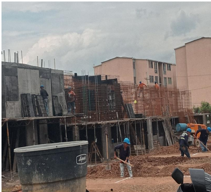
Figura 3. Instalación de malla electrosoldada en el segundo nivel
