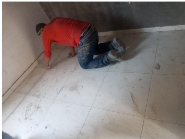
Figura 23. Instalación de cerámica
