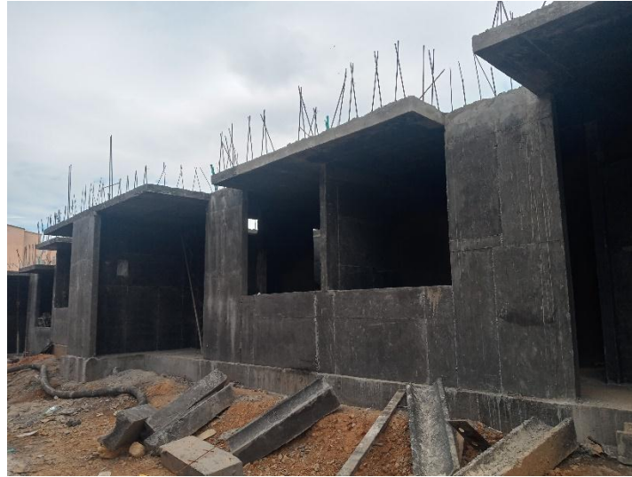
Figura 4. Arranques de 3/8" – placa entre piso
