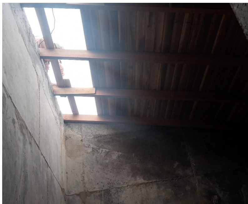
Figura 28. Ensamble de la tarima machimbrada
