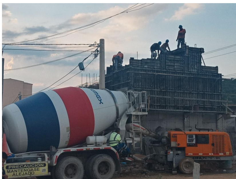
Figura 15. Vaciado de concreto con camión mixer y bomba convencional
