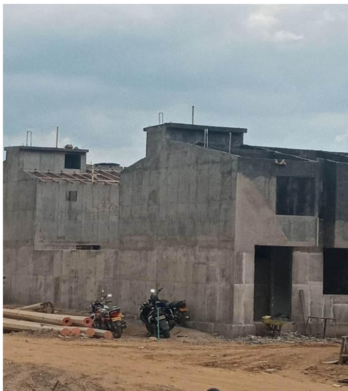
Figura 16. Obra negra completada
