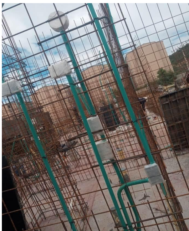
Figura 13. Evidencia de la instalación de tubería para el sistema eléctrico
