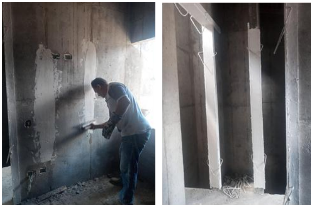
Figura 19. Estucado en marcas de formaletas y sección transversal de muros
