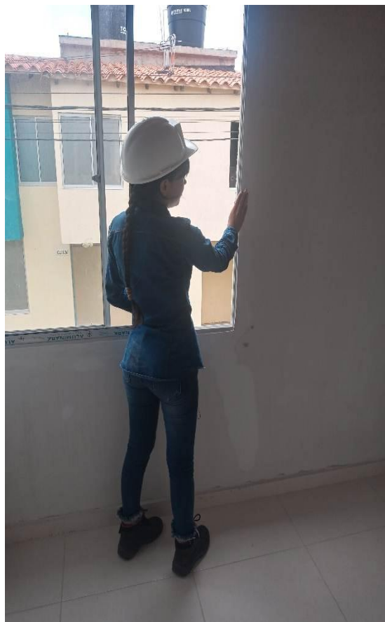
Figura 26. Inspección en la instalación de ventanas
