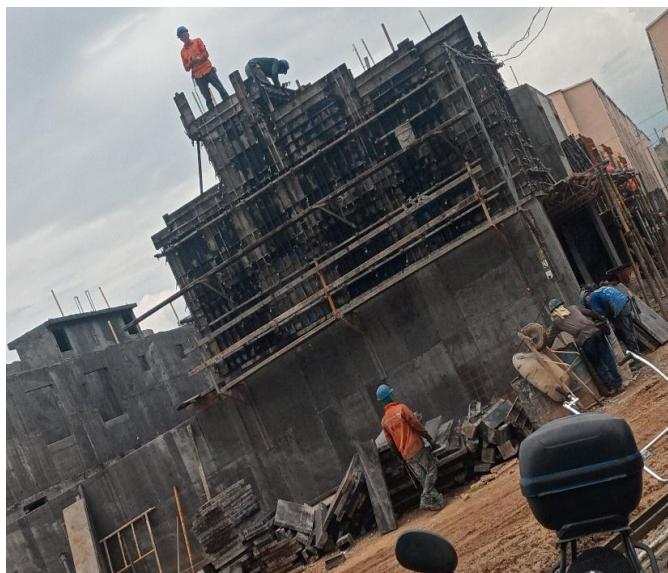
Figura 14. Encofrado del segundo nivel
