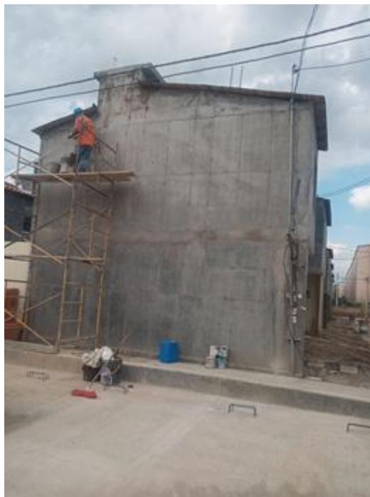
Figura 20. Inicio de la aplicación de Graniplast en exteriores
