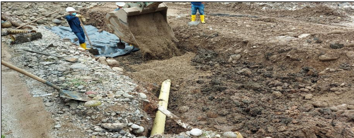
Imagen 11. Instalación de tubería sanitaria.
