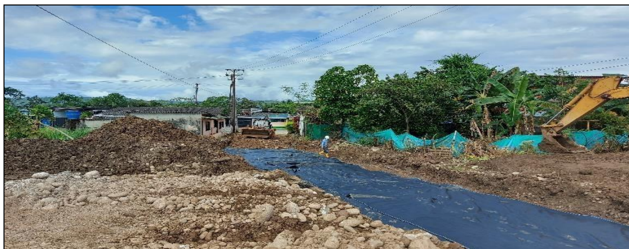
Imagen 4. Instalación del geotextil T-2400 en la zona
