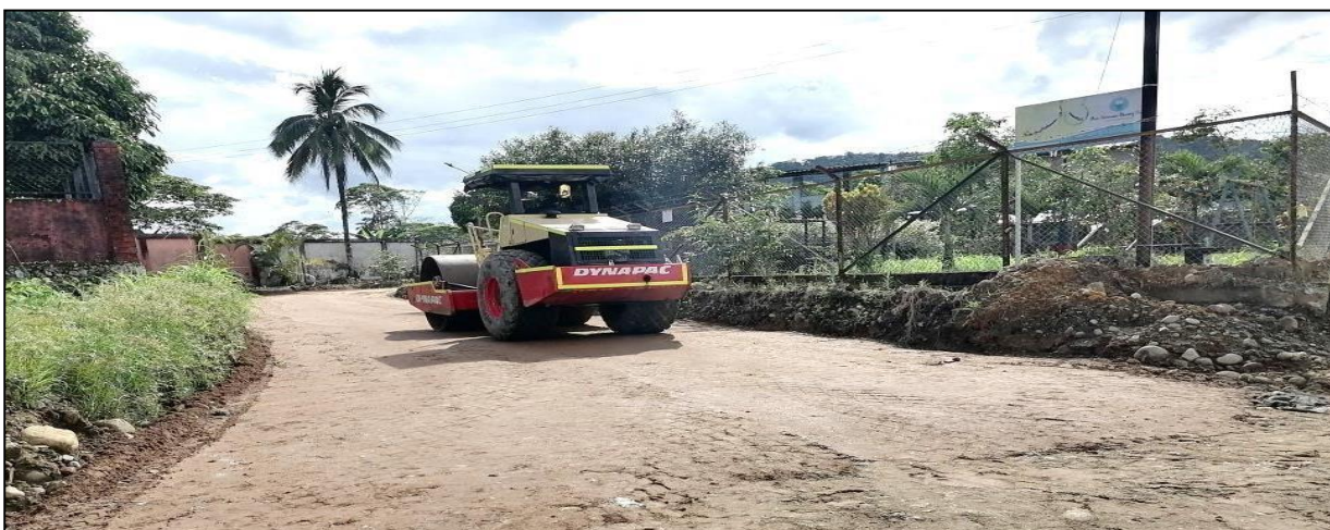
Imagen 19. Relleno seleccionado con material de excavación compactado
