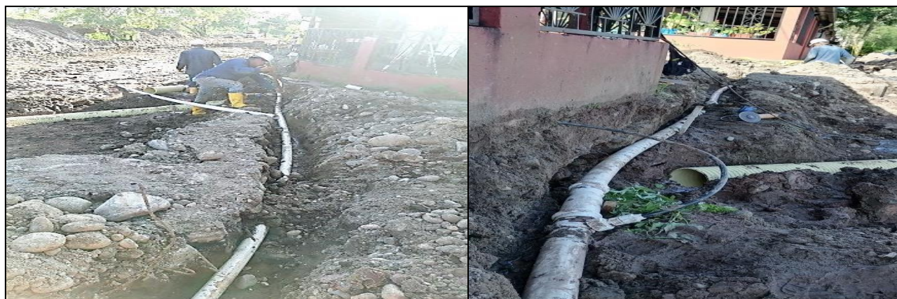
Imagen 16. Reposición de tubería sanitaria para la red principal ALL
