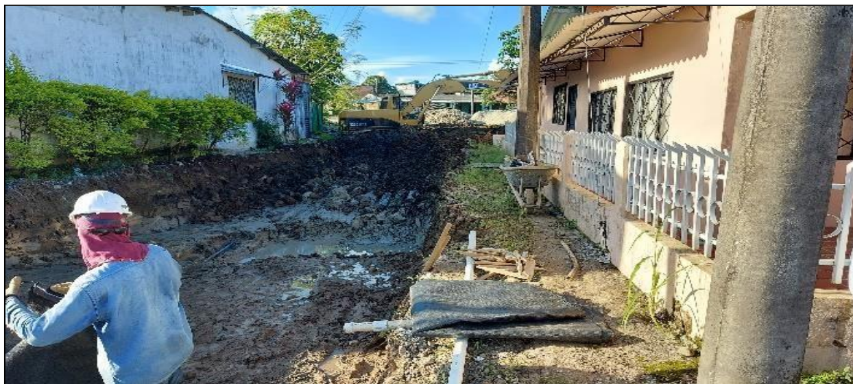
Imagen 18. Excavación mecánica para obras de alcantarillado
