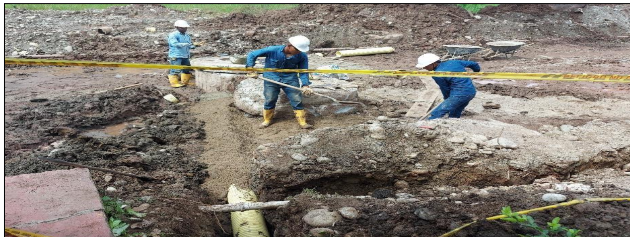
Imagen 13. Construcción de las cámaras de inspección del alcantarillado.
