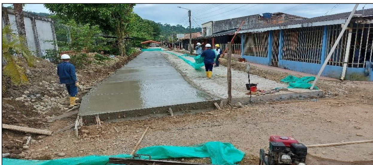
Imagen 9. Utilización de dovelas para la construcción del pavimento rígido con concreto de 4000 psi.
