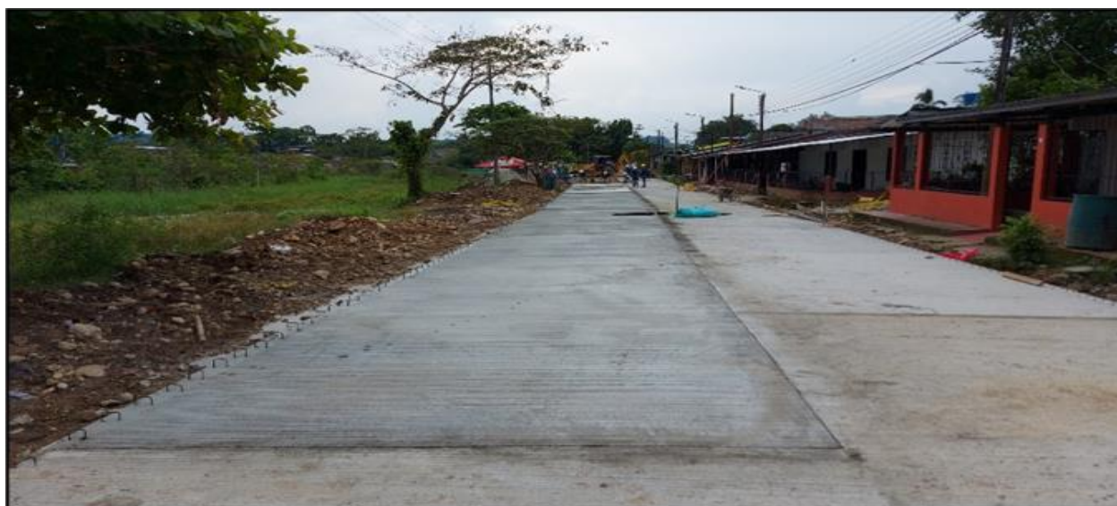
Imagen 8. Construcción en sitio de los bordillos con concreto de 3000 psi.
