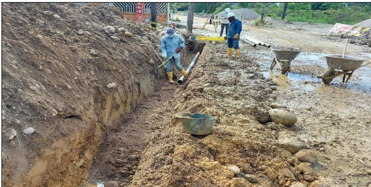
Imagen 14. Instalación de tubería para la conexión de las cámaras con los sumideros.
