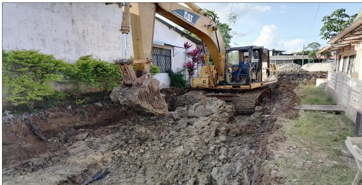
Imagen 2. Excavación mecánica de material común en la zona
