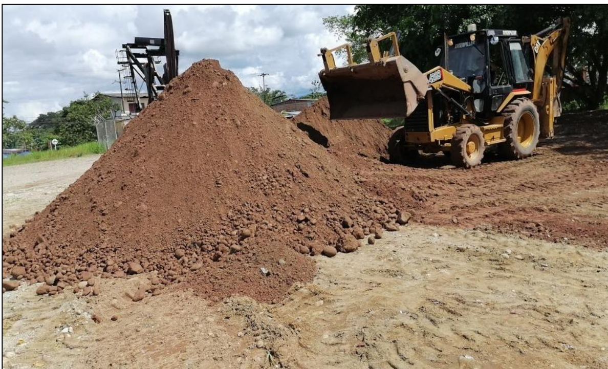
Imagen 6. Suministro e instalación de subbase granular.
