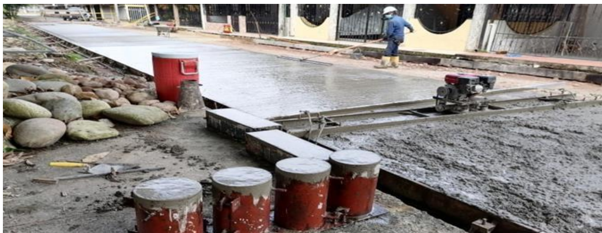
Imagen 7. Construcción del pavimento rígido con concreto de 4000 psi.
