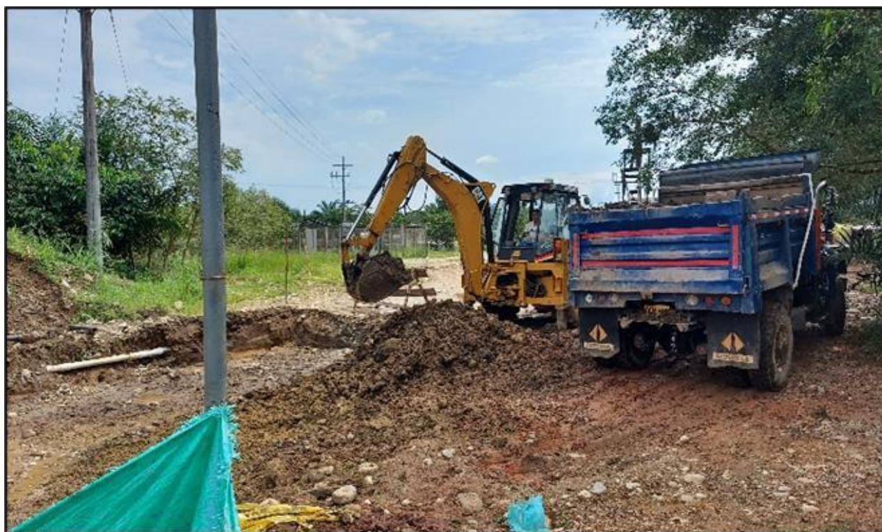
Imagen 3. Proceso de retiro de material de excavación.
