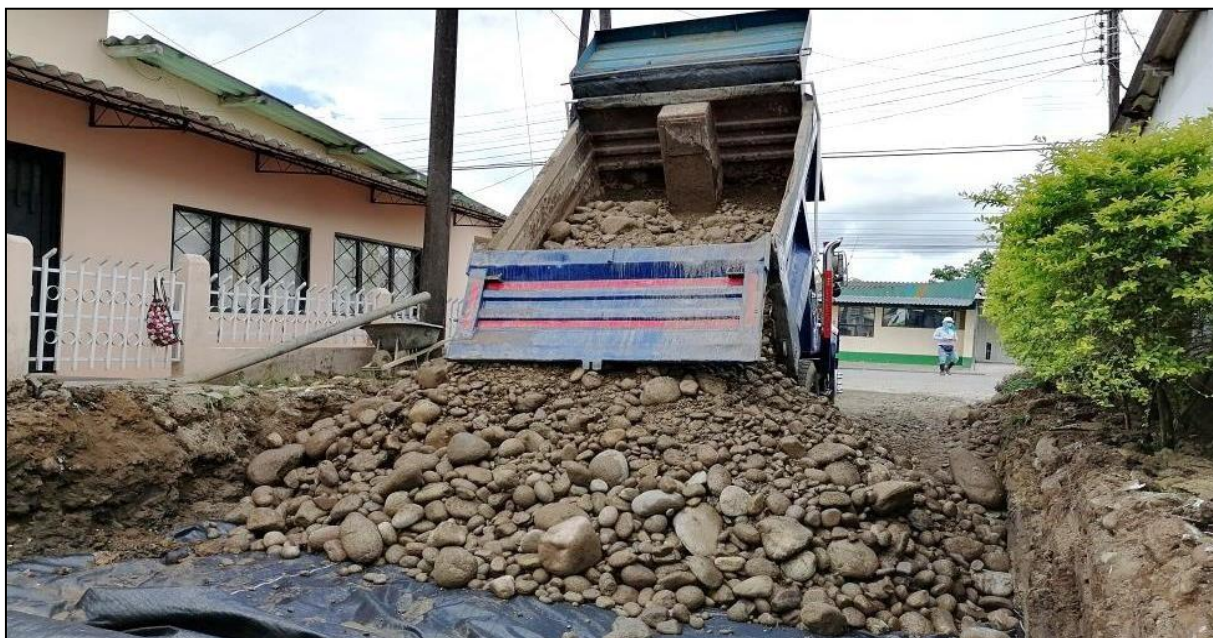
Imagen 5. Construcción del pedraplén.
