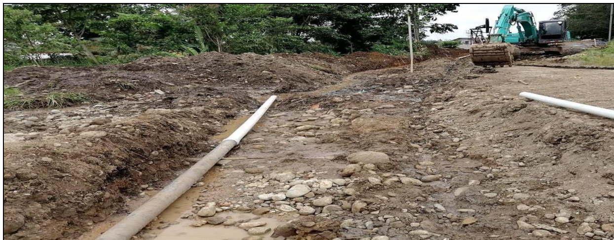
Imagen 17. Colchón de arena para tuberías
