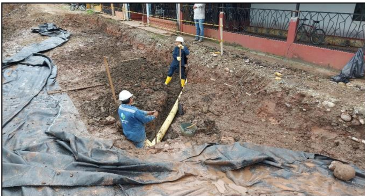
Imagen 10. Reposición de tuberías del sistema principal de alcantarillado.
