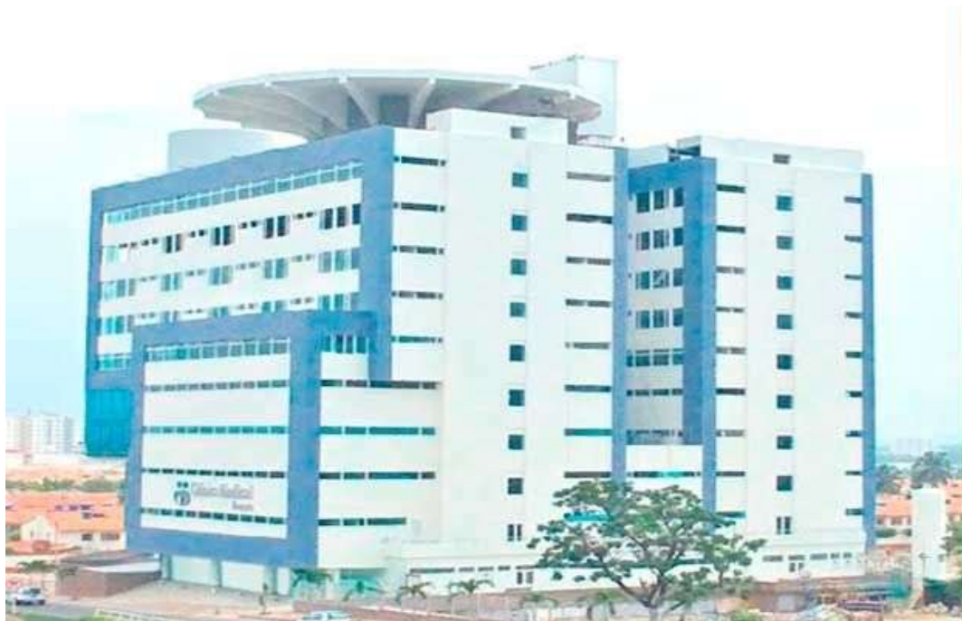
Ilustración 1: Estructura física Clínica Medical Duarte
