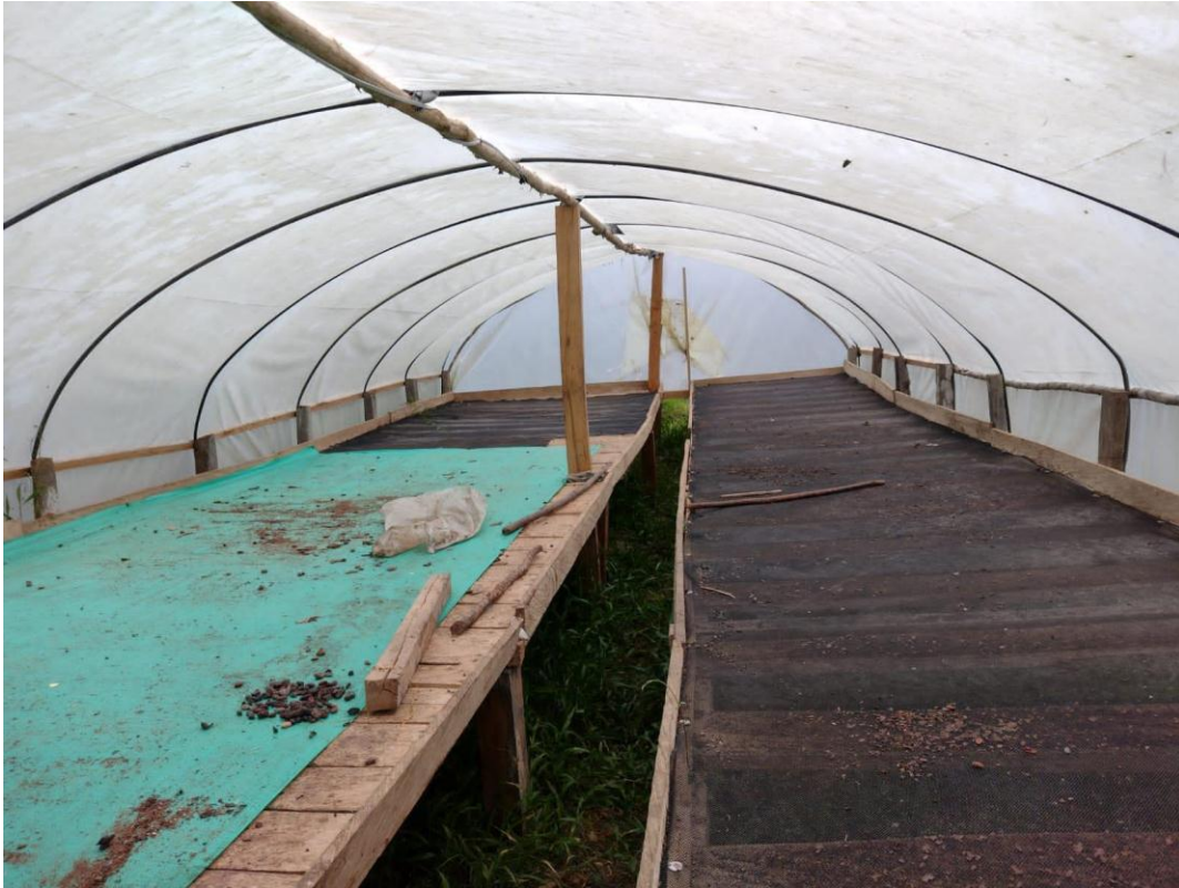
Figura 29. Implementación de marquesina en la zona rural
