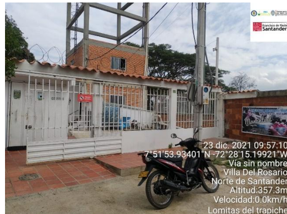
Figura 131. Instalaciones PTAP Lomita de los Trapiches
