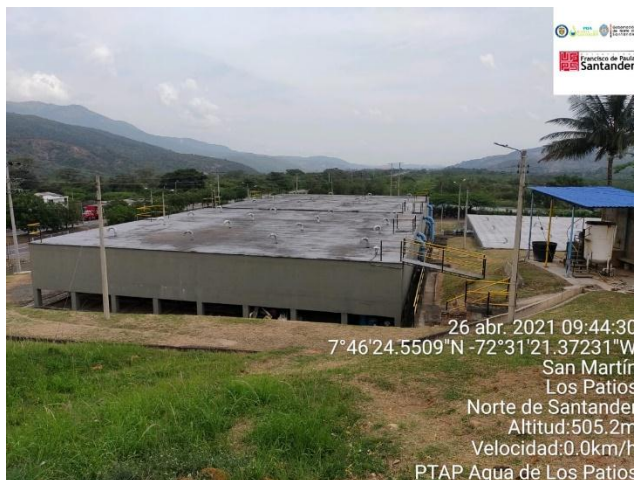
Figura 13. Tanque de almacenamiento. PTAP Agua de Los Patios
