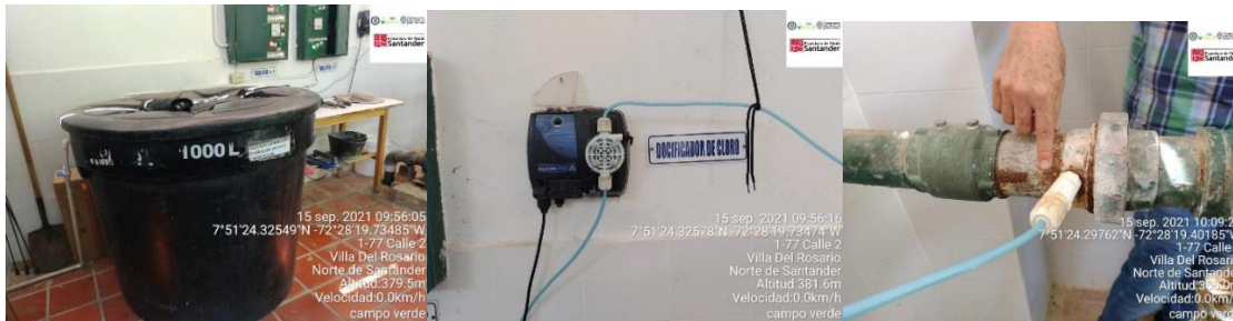
Figura 73. Tanque de preparación de cloro, dosificador de cloro y punto de mezcla de cloro con agua filtrada. ASOCAMVE
