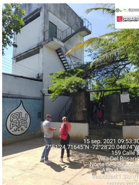
Figura 66. Instalaciones planta de tratamiento de agua potable Asociación de Usuarios Acueducto Campoverde
