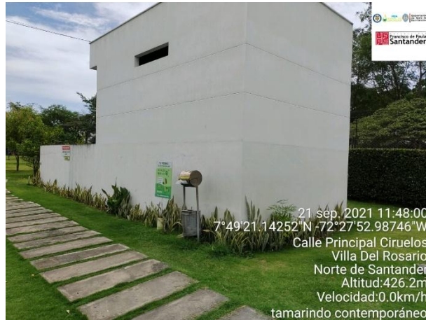
Figura 94. Instalaciones tanque de almacenamiento. PTAP Tamarindo Contemporáneo
