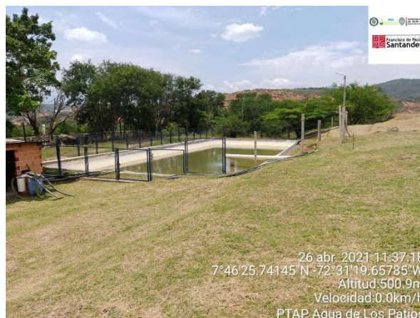
Figura 12. Piscina de descarga de lodos. PTAP Agua de Los Patios
