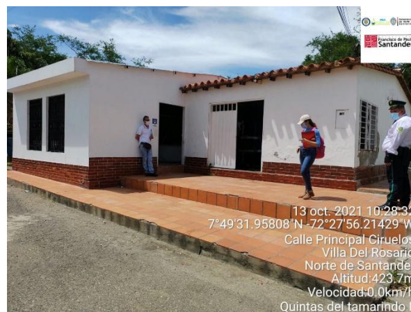
Figura 101. Instalaciones planta de tratamiento Quintas del Tamarindo II
