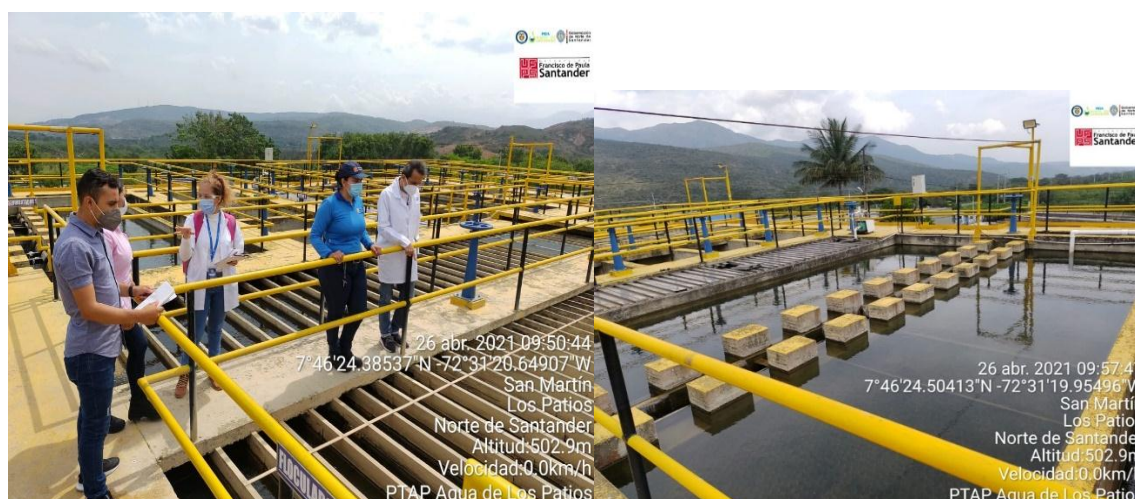
Figura 10. Estructuras del Floculador y Sedimentador. PTAP Agua de Los Patios
