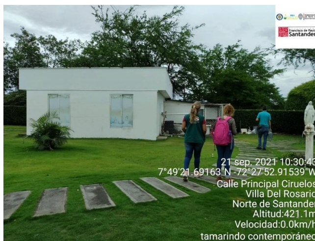
Figura 85. Instalaciones planta de tratamiento tamarindo contemporáneo
