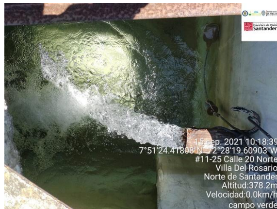
Figura 74. Tanque de almacenamiento. ASOCAMVE
