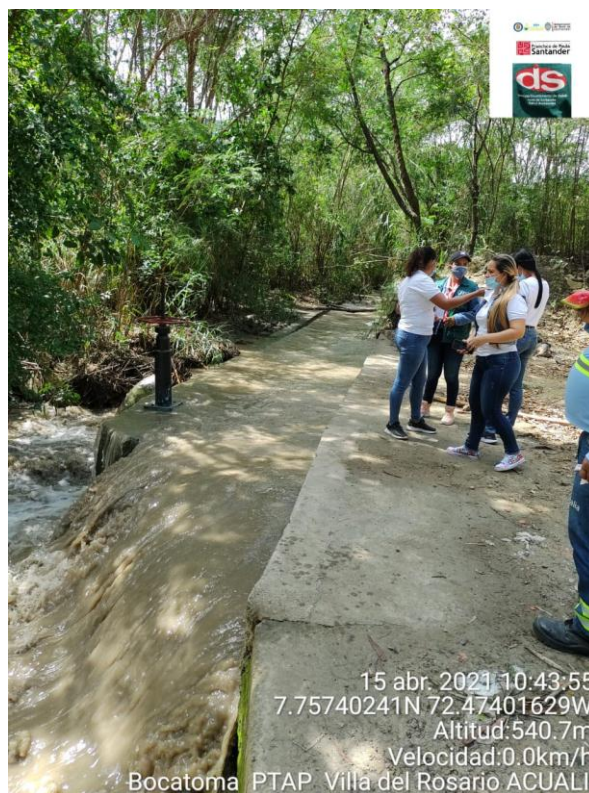
Figura 32. Estructura de la bocatoma lateral. AQUALIA
