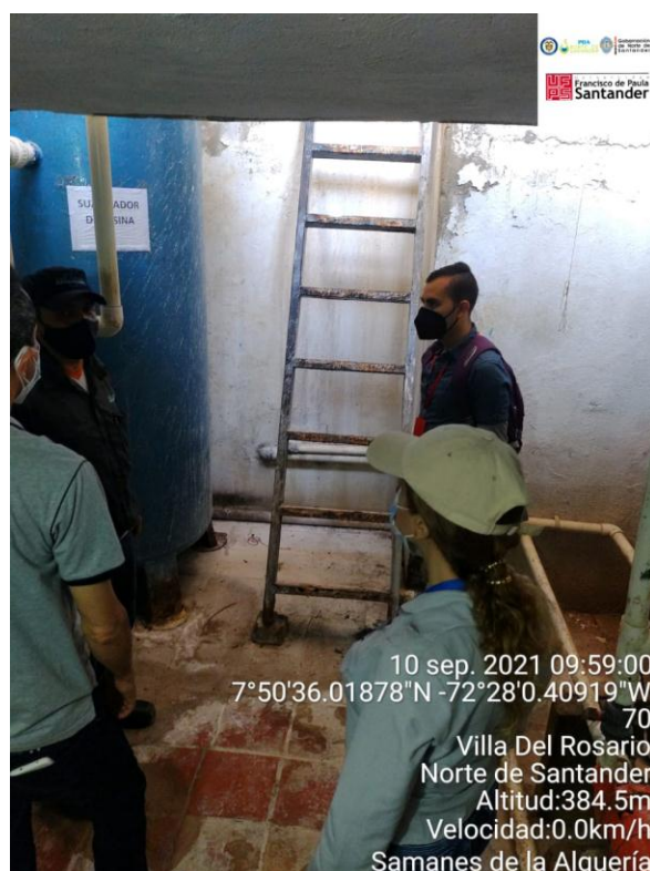
Figura 51. Suavizador de resina. PTAP Samanes de los Trapiches
