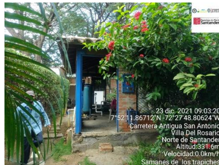
Figura 123. Instalaciones PTAP Samanes de los Trapiches
