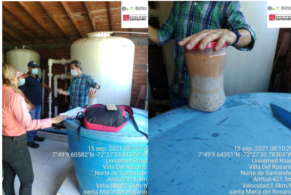
Figura 60. Suavizador de intercambio catiónico PTAP Santa María del Rosario
