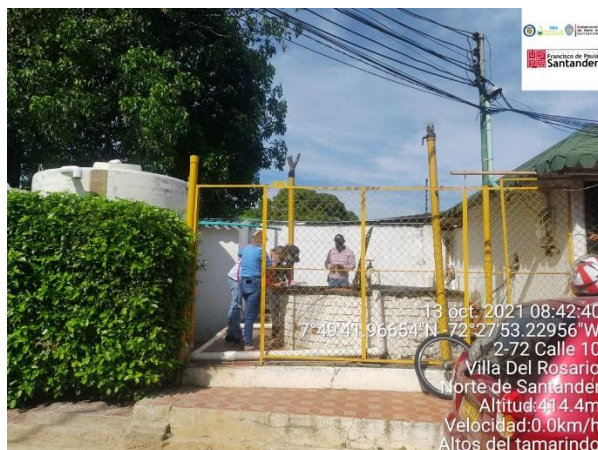
Figura 95. Instalaciones planta de tratamiento Altos del tamarindo
