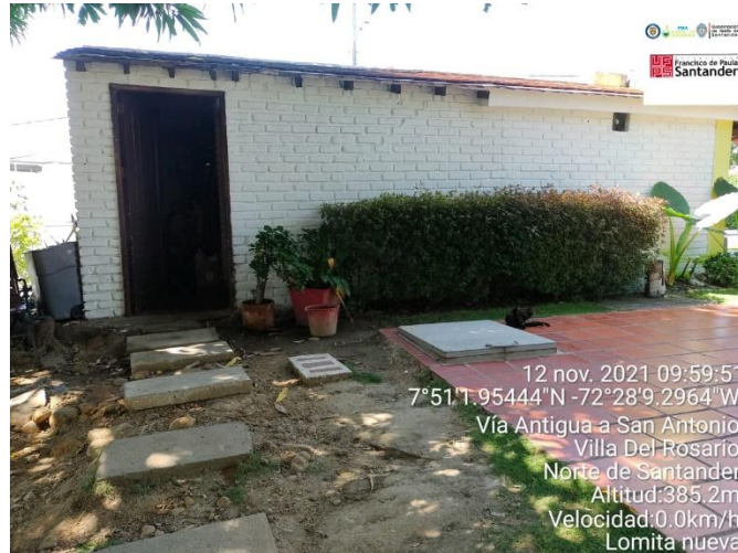
Figura 115. Instalaciones PTAP Lomita Nueva
