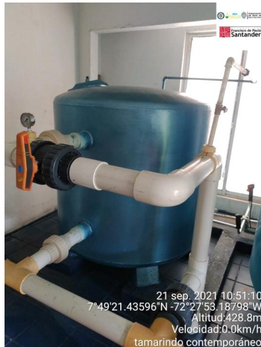
Figura 88. Batería filtrante número 1, arenas finas. PTAP Tamarindo Contemporáneo
