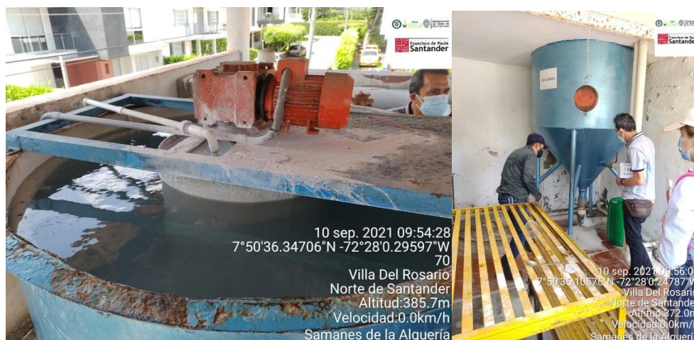
Figura 48. Floculador en cono PTAP Samanes de la Alquería. PTAP Samanes de los Trapiches
