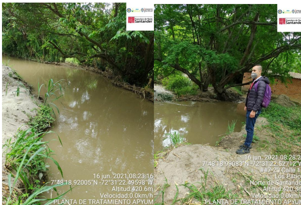
Figura 26. Desvío Duplac, bocatoma de la planta APYUM
