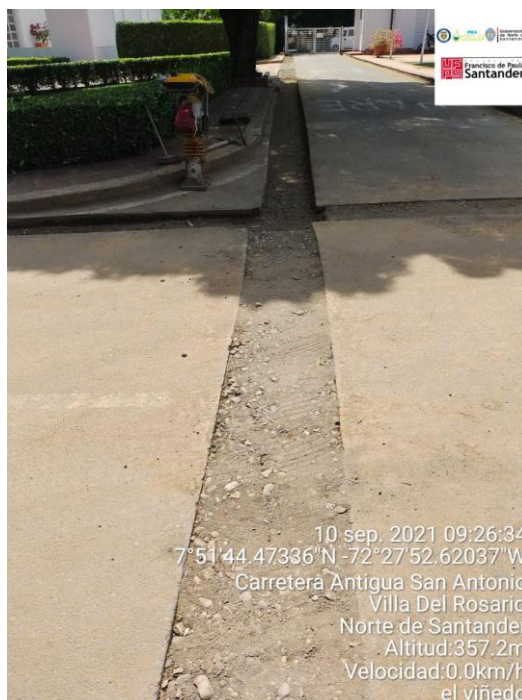
Figura 43. Instalación de tuberías para posible conexión a red de distribución externa.
