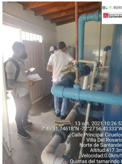
Figura 106. Inspección y recomendación dadas al operario planta Quintas del Tamarindo II
