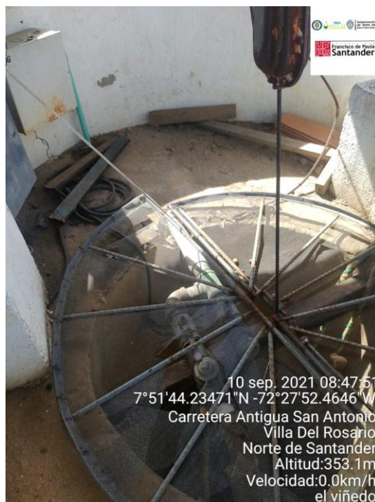
Figura 40. Estado actual del pozo de abastecimiento, unidad prestadora del servicio de agua potable el viñedo
