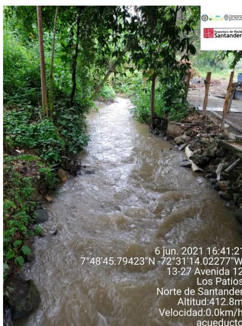
Figura 14. Fuente de abastecimiento (desvío Duplac). PTAP Tierra Linda
