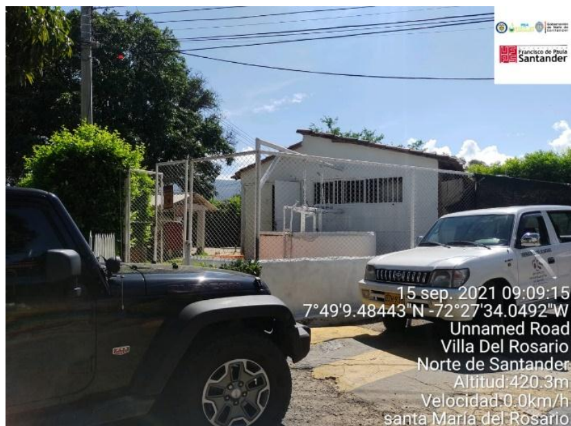
Figura 57. Planta de tratamiento de agua potable Santa María del Rosario
