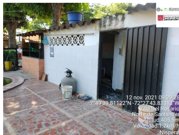
Figura 109. Instalaciones unidad prestadora del servicio de agua El Nisperal
