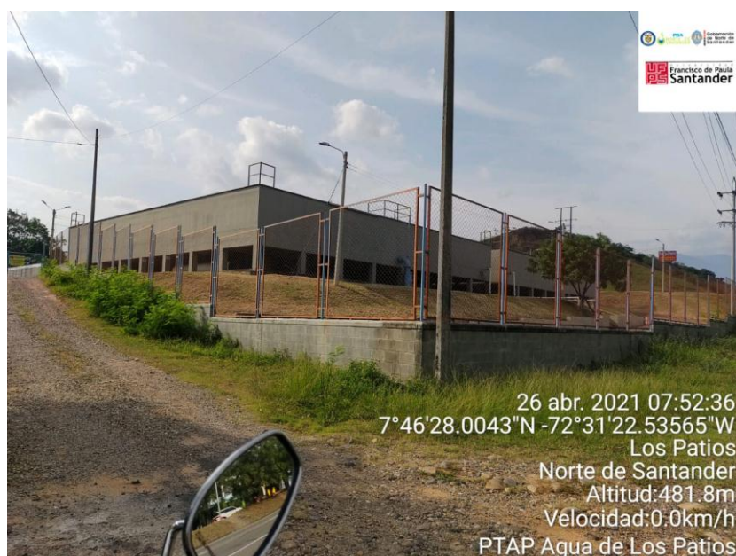
Figura 7. Planta de tratamiento los Vados (Agua de Los Patios)
