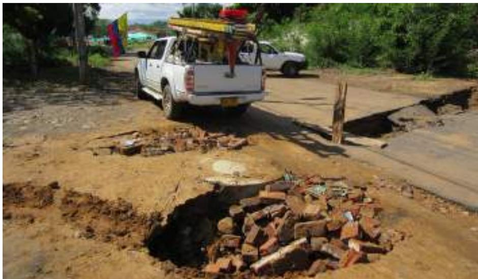
**Figura 125. Colapso de vías por precipitaciones**
