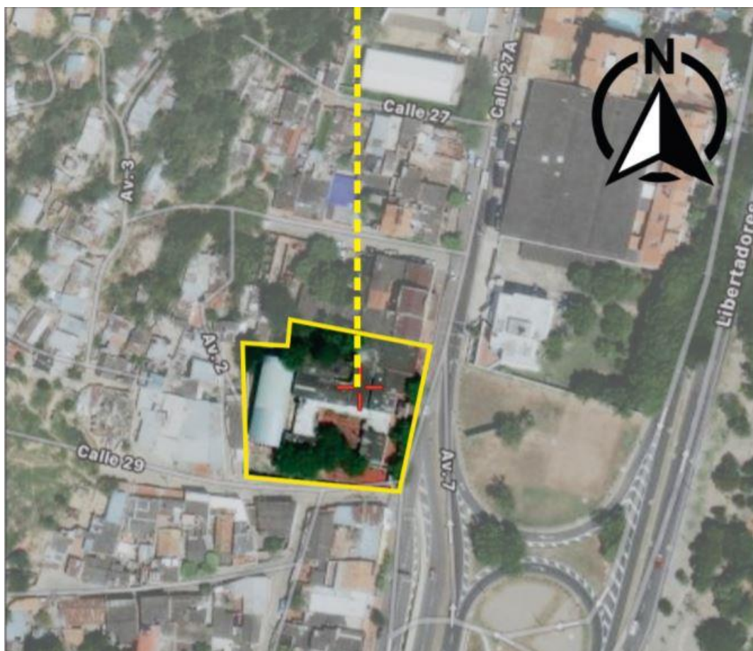
Figura 2 Localización satelital y planimetría de la planta cocina - comedor de la institución educativa Luis Carlos Galán Sarmiento Sede No 3 La Alianza Para el Progreso de la ciudad de San José de Cúcuta, Norte de Santander.
