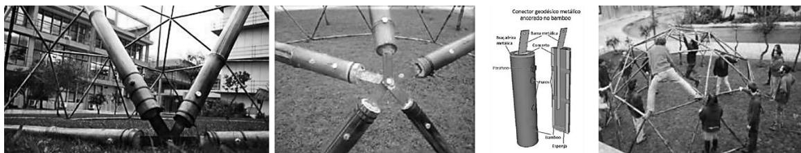
Figura 76. Estructura geodésica con módulos de barras planas metálicas
