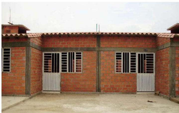
Figura 79. Fachada casa tipo Urbanización García Herreros IV, año 2009
