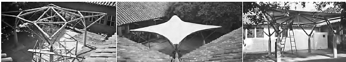
Figura 68. Estructura espacial con unión de esferas metálicas
