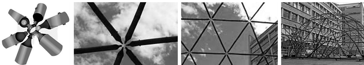
Figura 70. Unión moderna de botellas pet, cilindro de hierro y guadua
