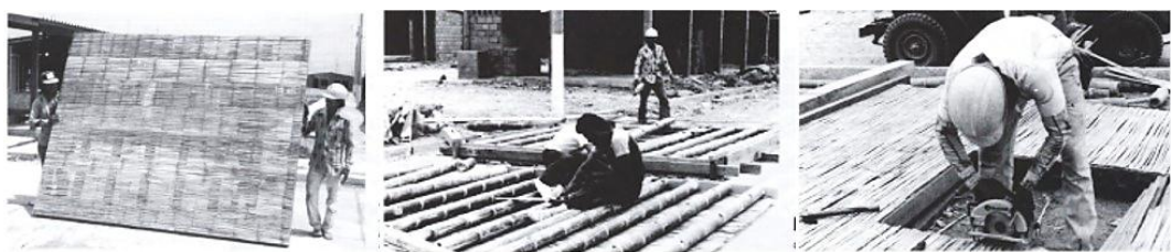
Figura 57. Panel con esterillas de bambú para viviendas residenciales
