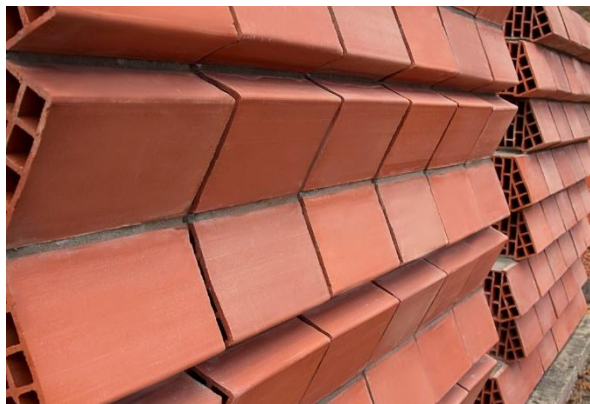
Figura 94. Muro con Bloque Termodisipador
