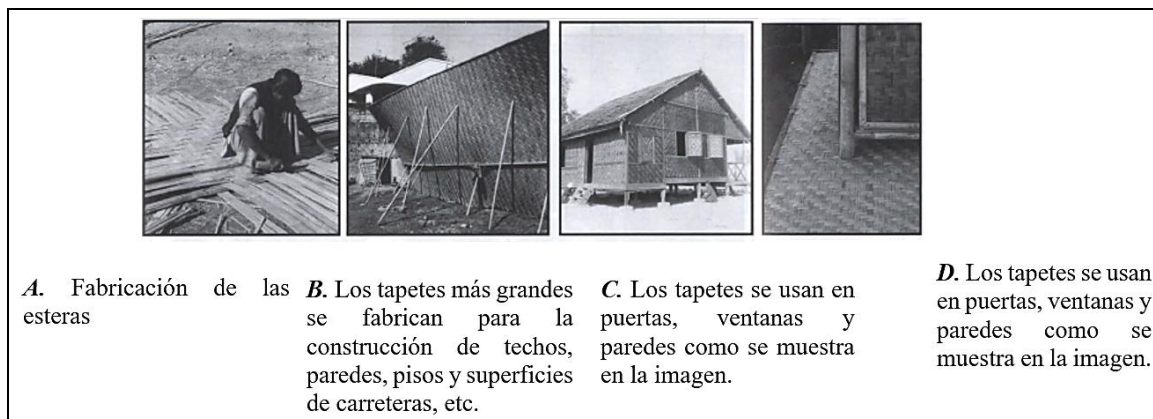
Figura 26. Aplicación de tejidos de guadua en la construcción
