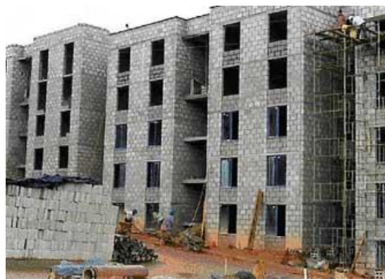
Figura 87. Ejemplo de sistema constructivo en mampostería estructural
