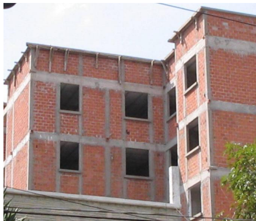
Figura 86. Mampostería confinada compuesto de bloques de arcilla
