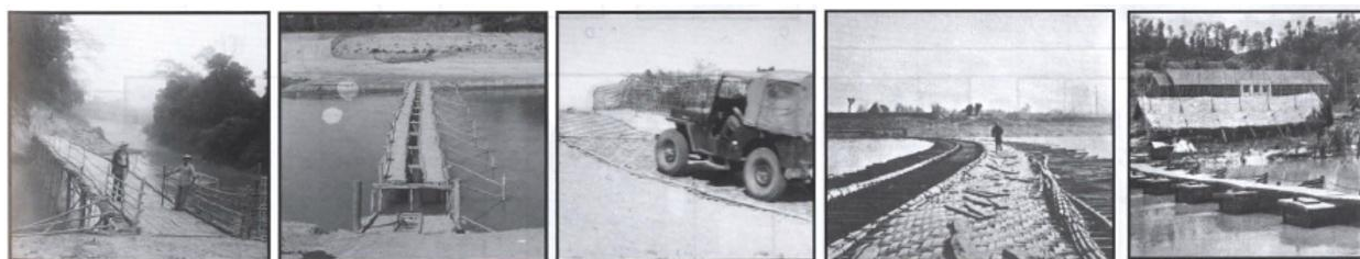
Figura 27. Estera de bambú utilizada como superficie en puentes y caminos
