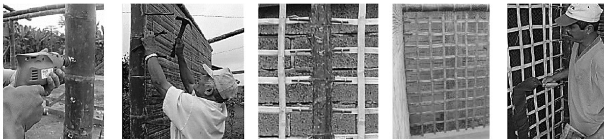
Figura 52. Estructura de latillas horizontales y verticales
