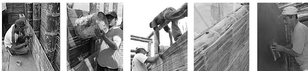
Figura 55. Pared de esterilla recubierta con cemento
