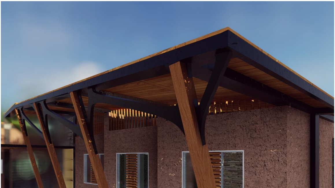
Figura 132. Vista frontal. Cubierta y detalle perfil metálico.
