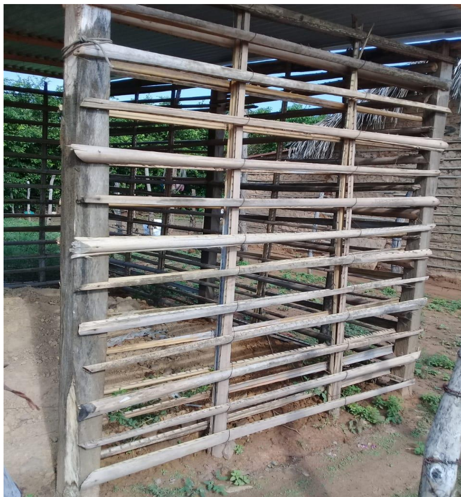
Fotografía 13. Modulación empírica de sistemas constructivos con Raquis de palma en el municipio de Pelaya.
