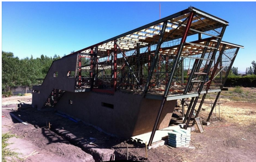
Fotografía 3 Proceso constructivo, estructura y piel en acero y tierra. Pablo Alvear (Arias Arquitectos y Surtierra Arquitectura, 2013).
