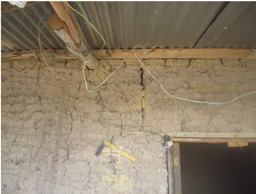
Fotografía 54. Vivienda de bahareque en La Fortaleza. (Detalle muro).
