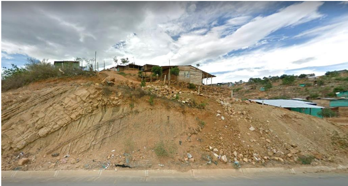
Fotografía 23. Estratos rocosos e implantación. Viviendas. Google Earth (2018).
