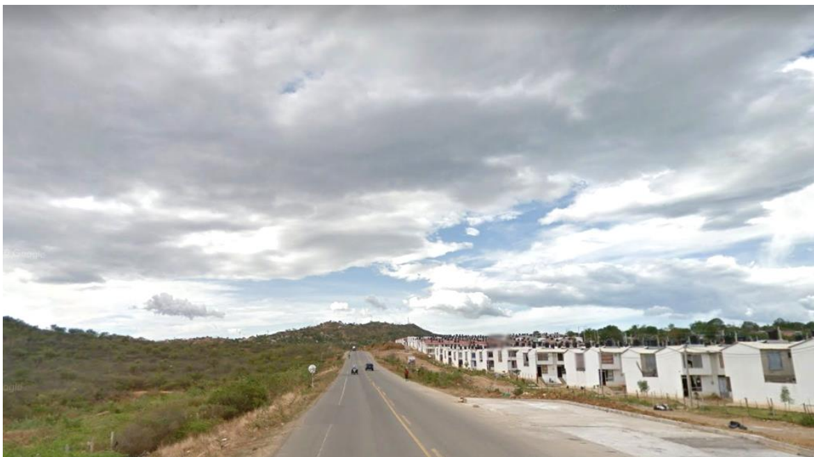
Fotografía 49. Viviendas en el Sector El Rodeo. Google Earth Pro (2010-2018).
