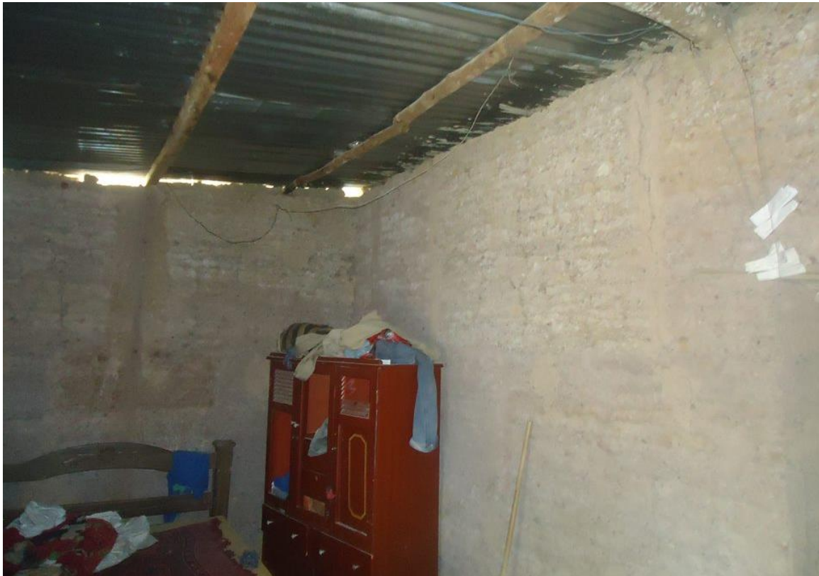
Fotografía 56. Vivienda de bahareque. La Fortaleza. (Interior).
