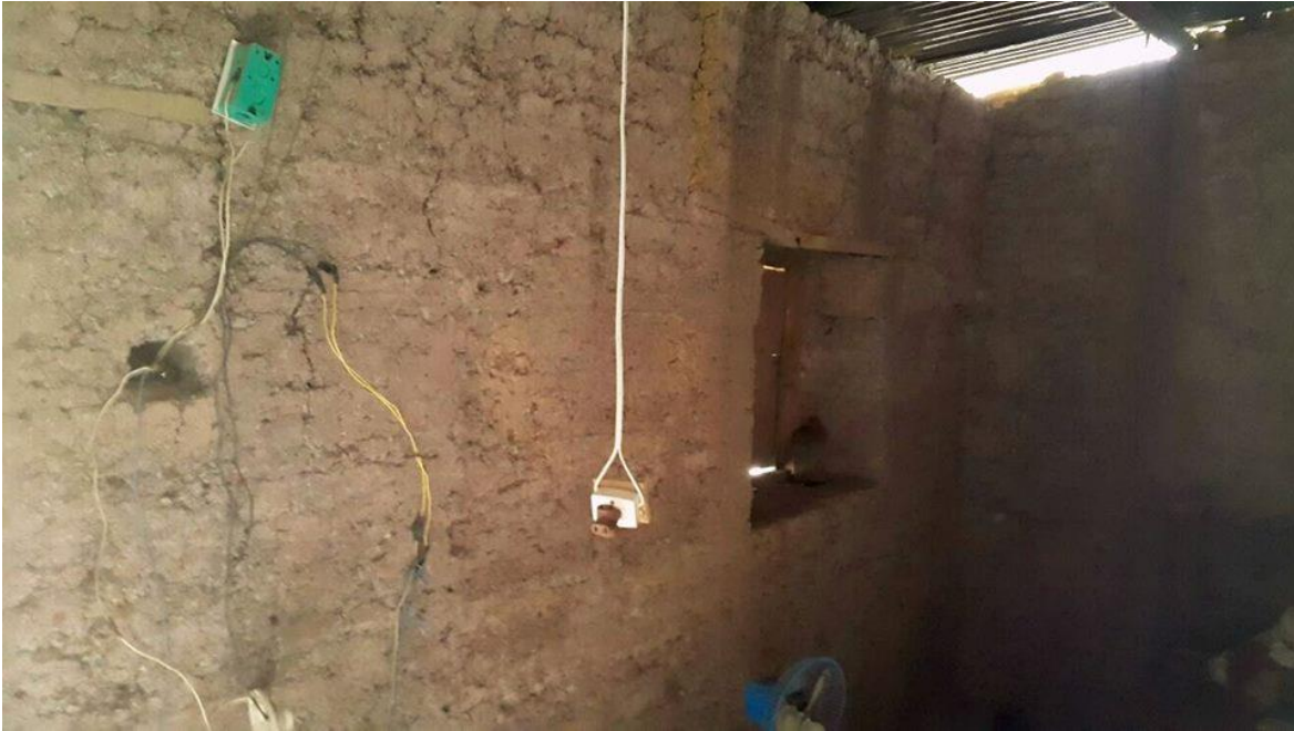
Fotografía 55. Vivienda de bahareque. La Fortaleza. (Detalle ventana).
