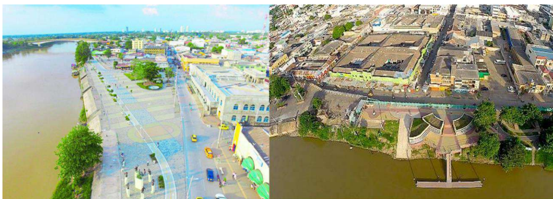
Ilustración 2 . Renovación urbana del malecón de Lorica ciudad de Montería Córdoba, Colombia.
