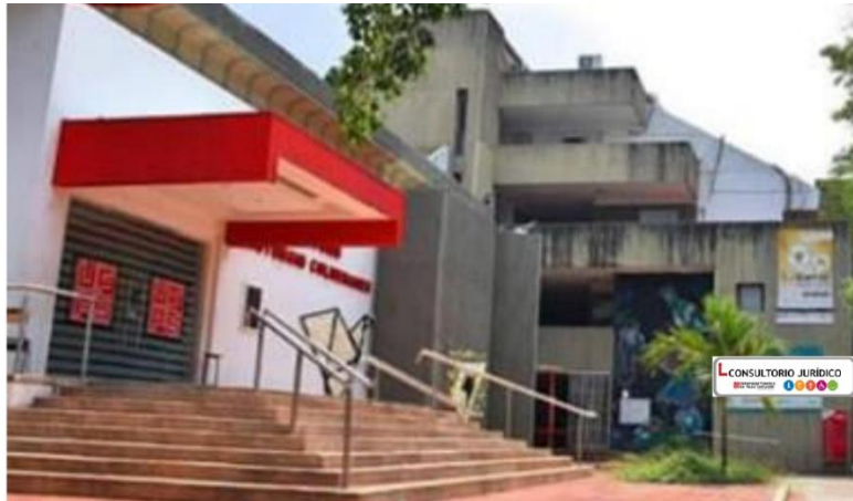
Figura 14. Lugar de instalación de señalización del Consultorio Jurídico
