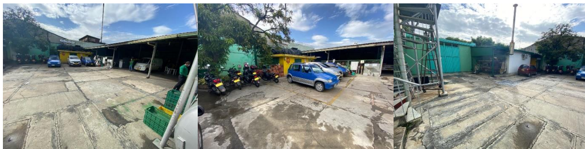
Figura 40. Estado vías internas
