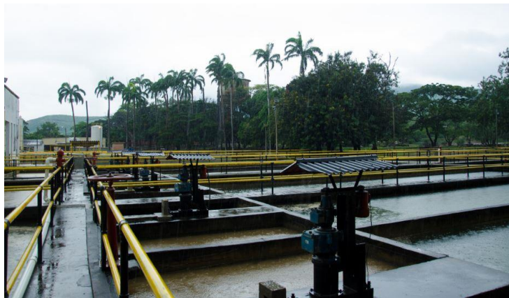
Figura 3. Tanques del proceso de floculación en la planta de tratamiento del pósito.
