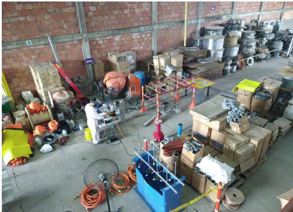
Figura 11 Certificación de equipos dieléctricos
