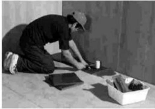
*Figura 1.* Método tradicional de pegado de baldosa (Cordilleras diseños del mundo, 2004).
