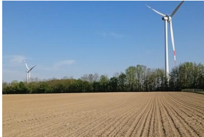
Figura 154. Aerogenerador Enercon E115/3000. Tomado de: ( The Wind Power , 2022).
