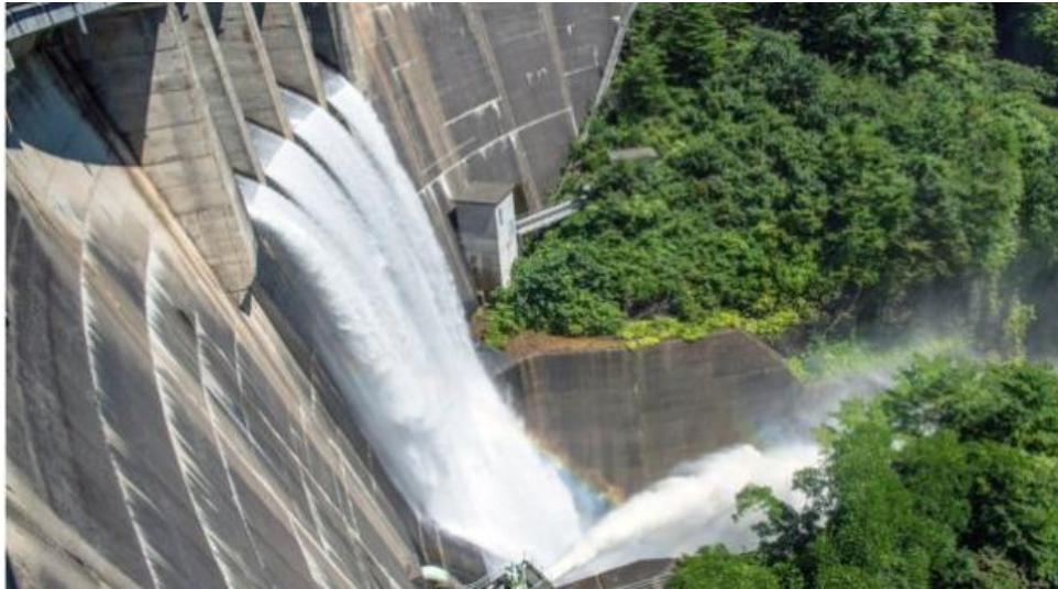
Figura 3. Represa Construida Con Cemento Portland Tipo II
