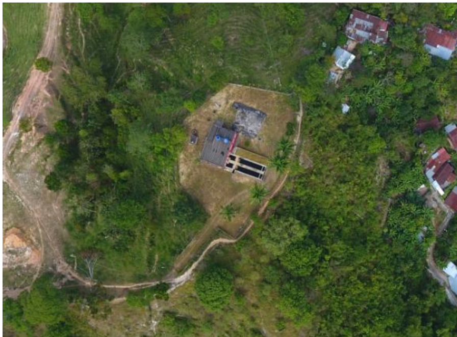
Figura 63. Foto Aérea Planta de Tratamiento de Agua Potable Durania
