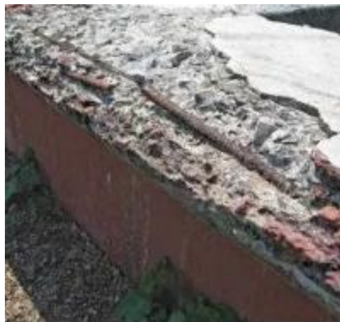
Figura 28. Lavado de la Pasta Superficial en una Viga
