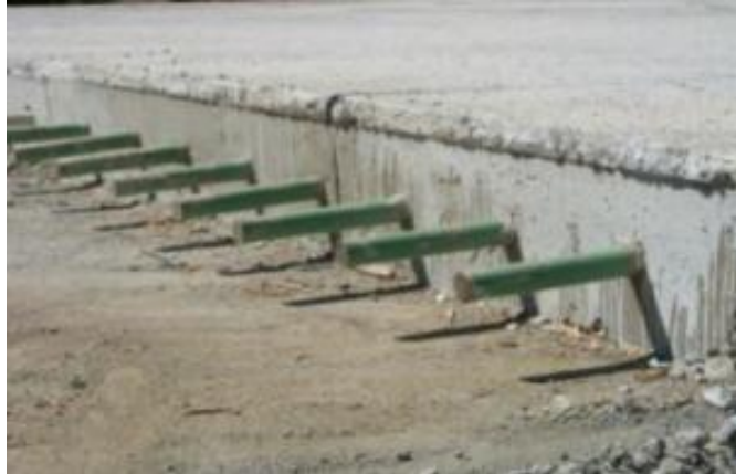
Figura 29. Línea entre Capas (Junta Fría)
