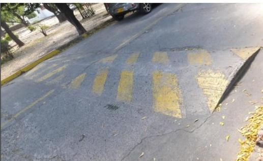
Fotografía N32: VIA INTERNA UNIVERSIDAD FRANCISCO DE PAULA SANTANDER, reductor de velocidad en pesimas condiciones de pintura
