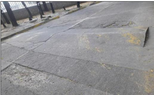
Fotografía N°36: VIA INTERNA UNIVERSIDAD FRANCISCO DE PAULA SANTANDER.reductor de veocidad en pesimas condiciones estructurales y de pintura
