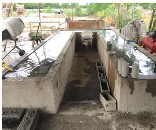
Pileta de curado de muestras de concreto
