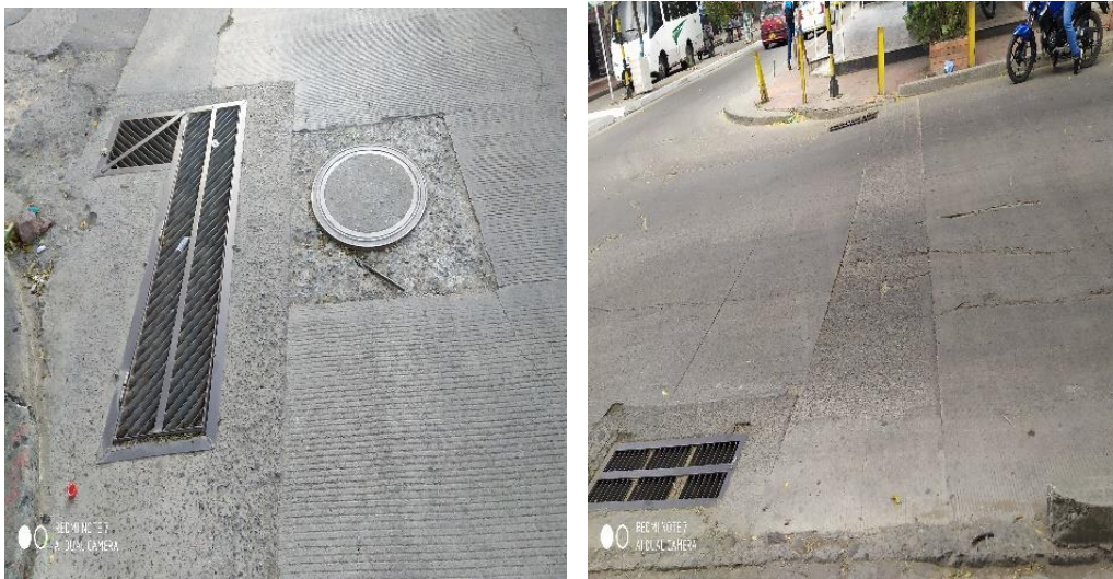
Figura 16 Auscultación de pozos y sumideros Fuente: Autor
