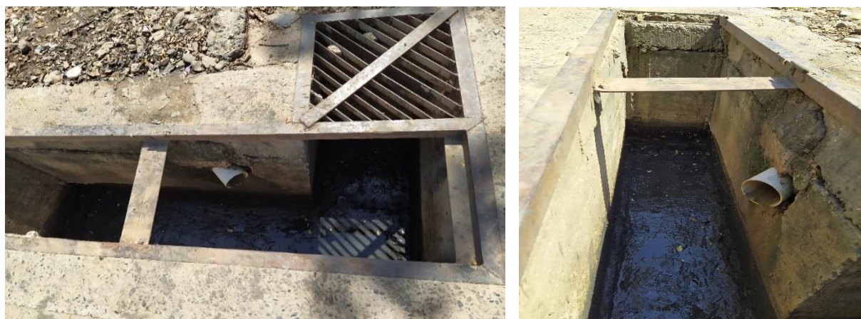
Figura 15 Auscultación de sumidero tipo L Fuente: Autor
