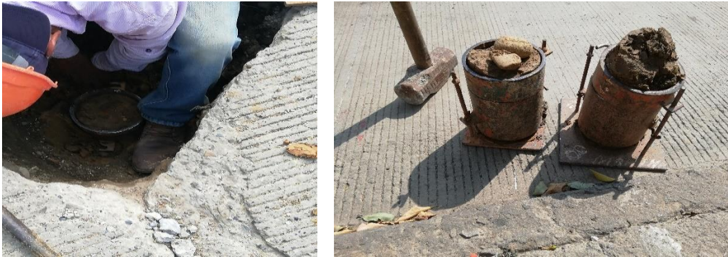
Figura 7 Muestras para realización de ensayo de CBR Fuente: autor
