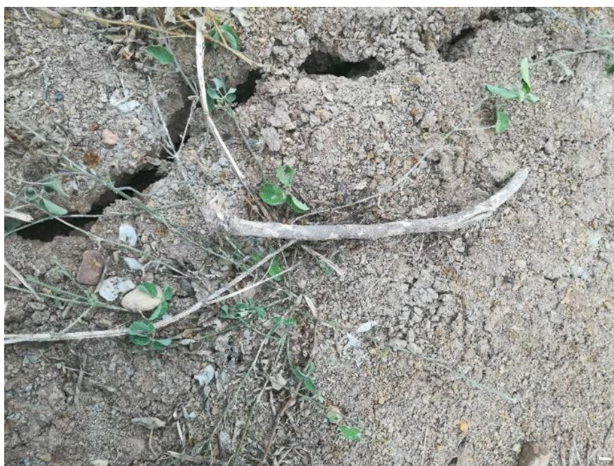
Figura 18. Grietas de desecación en el terreno
