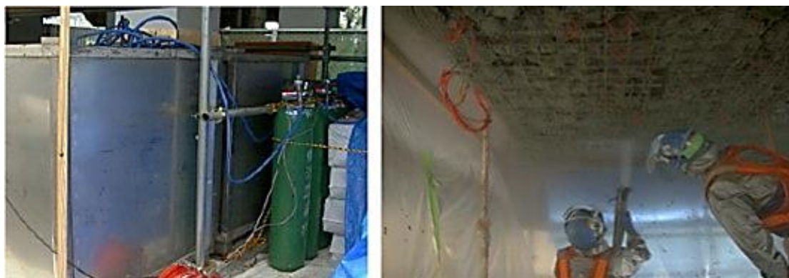
Figura 66. Configuración de carbonatación de etanolamina y spray de solución inhibidora. (Kubo et al., 2013)
