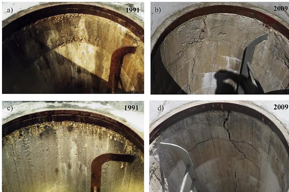
Figura 100. Puntos de acceso al sistema de péndulo: a y c) pozo 1 y pozo 2, respectivamente, en 1991, b y d) pozo 1 y pozo 2, respectivamente, en 2009. (Campos et al., 2018)
