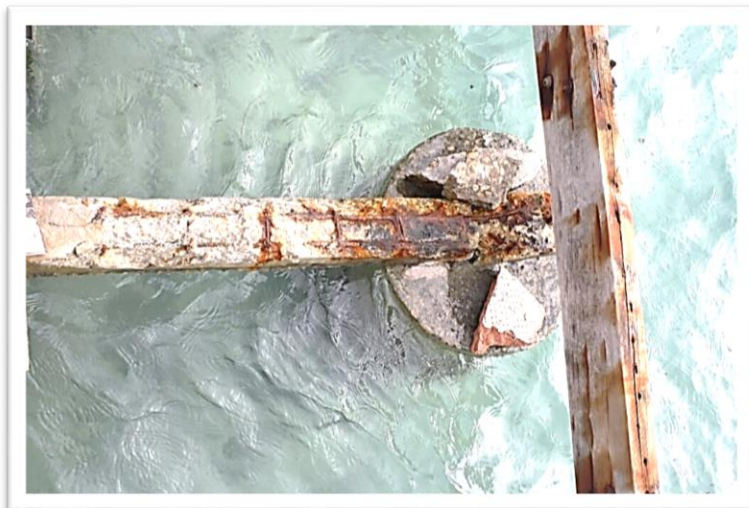
Figura 1. Ataque externo de sulfato en el concreto. (Londoño, n.d.)
