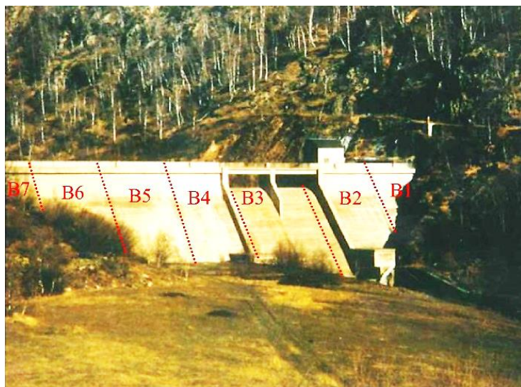
Figura 94. Vista de la presa de aguas abajo. Campos, López, Blanco, & Aguado, 2018
