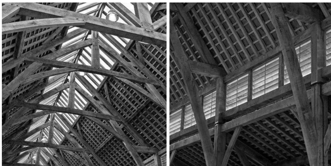
Figura 9 Cercha gótica de madera.
