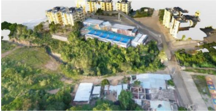
Figura 11. Modelo 3D de la Zona de Estudio Elaborado a partir de ortofotografías tomadas con un dron DJI Phantom 4.
