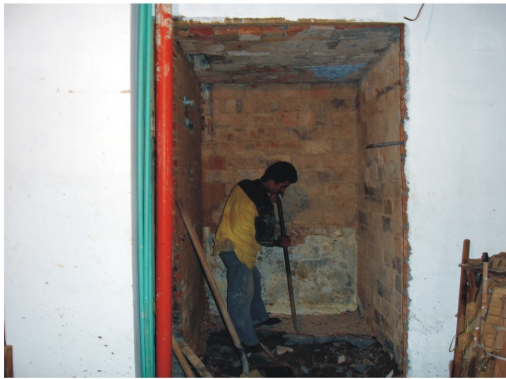
Corresponde al bajante de aguas lluvias de la columna D4 y a la tubería de 1/2 de la parte eléctrica de el primer piso.
