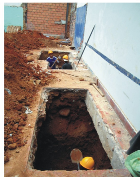
Vista de las excavaciones del eje 7, de las zapatas A, C, D, con cuadrilla 0-2 es decir, 0 oficiales y 2 ayudantes.
