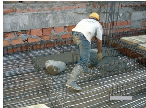
Una vez colocada la malla de vena se procede a echar la torta que se realiza con un mortero pobre, este será la cara inferior de la placa.
