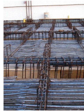
Las vigas y viguetas se deben amarrar a la malla con vena para que trabajen como una sola.
