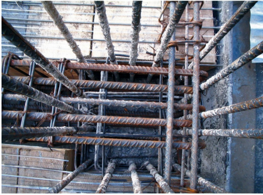
Vista interna de los hierros de la columna C7.
