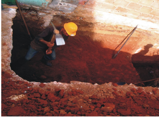
Proceso de excavación de la zapata D1 dimensiones 1.7*2.1 y profundidad 2.6mt.
