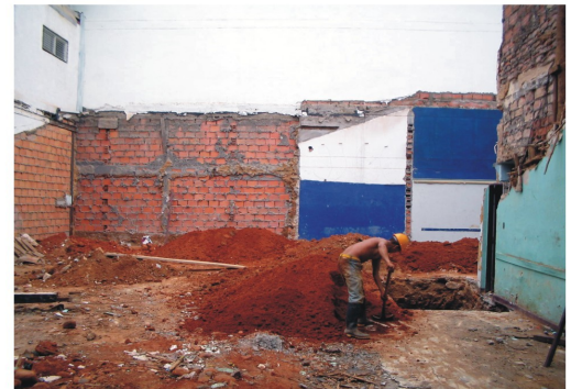
Es importante mantener la obra libre de materiales inoficiosos, para esto se realiza el movimiento de tierra, que libera la obra de el material que en este caso no se utilizara para relleno y sera evacuado por las volquetas.
