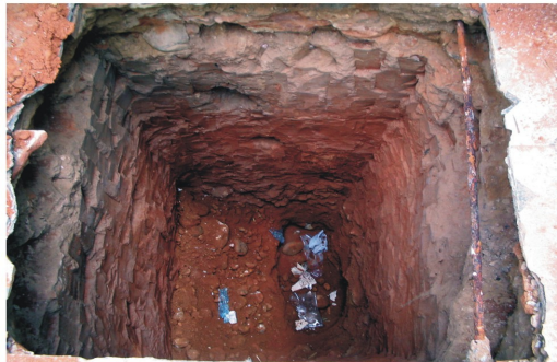
Excavación de la zapata G7 con una profundidad de 3.35mt para verificar mediante el respectivo estudio de suelos que el terreno es apto para la cimentación.
