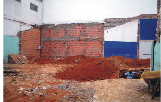
Terreno listo para el inicio de la excavación de zapatas, el material de relleno se debe colocar cerca de las excavaciones bien sea para sacarlo de la obra o utilizarlo nuevamente como relleno.
