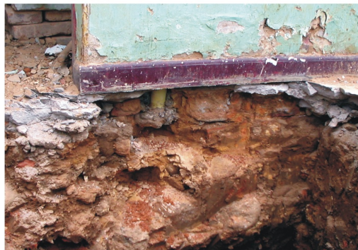
Los imprevistos hacen parte de cualquier obra, estos mediante la ejecución de cualquier actividad se pueden presentar, durante esta excavación se encuentro tubería de desagüe de la edificación vecina.
