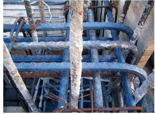
Para amarrar una viga a una columna es necesario verificar que los ganchos se realicen según la medida de los planos, pues ellos son los que actúan durante los sismos.
