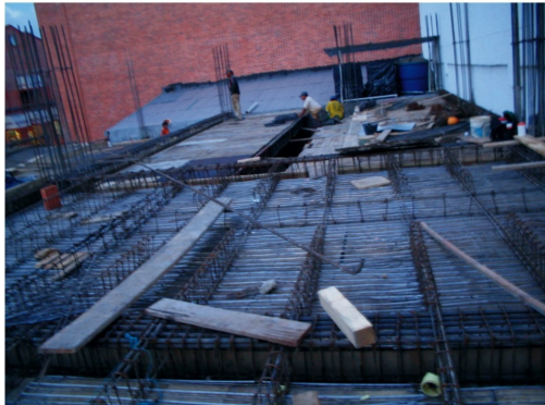
Estas actividades se pueden realizar simultáneamente en este caso la elaboración de la placa se dividió en 3 tramos que se trabajaron conjuntamente.
