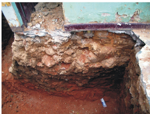
Detalle antigua cimentación zapata D4.
