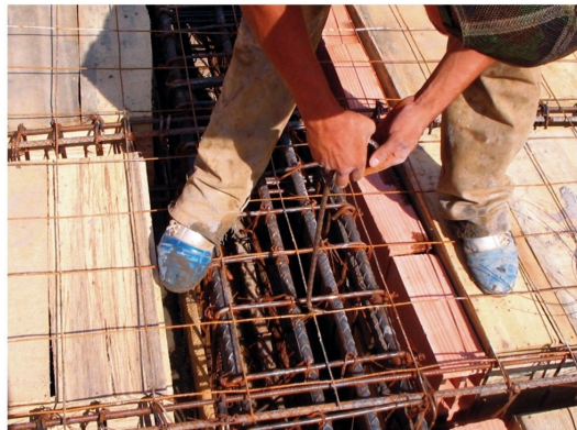
El bichiroque es la herramienta que se utiliza para amarrar los hierros con alambre, es una varilla de \frac{3}{4} o \frac{1}{2} con un gancho afilado al final.
