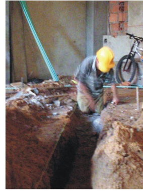
Se realizan los cálculo correspondientes para hallar la pendiente con la que se instalara la tubería, para evitar que el agua se estanque o se devuelva.
