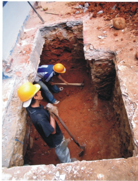
Proceso de excavación de las Zapatas morochas D7 y E7.
