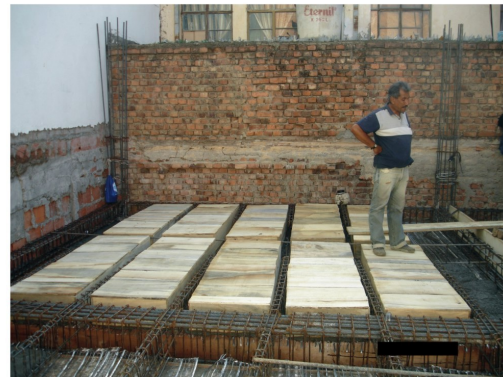
El aligeramiento como muestra la imagen se coloca en los vacíos entre las vigas y los nervios, busca reducir cargas y costos en la obra, es un método muy comercial.
