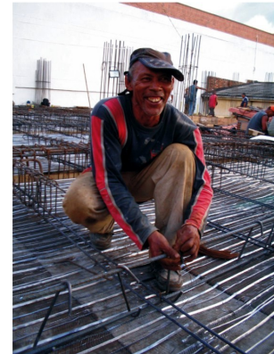
Los nervios deben quedar sujetos adecuadamente a las vigas perimetrales.
