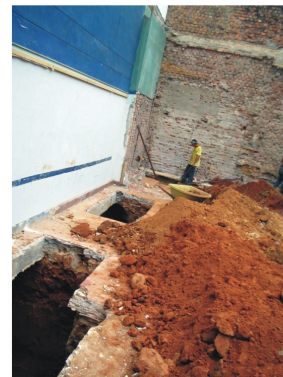
En esta imagen se pueden apreciar la excavación de las zapatas del eje 7 como lo son D, E, F, G.
