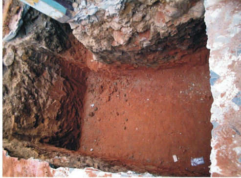
Nivelación de la zapata D3y D4, falta por emparejarle los costados para proceder a fundirla.
